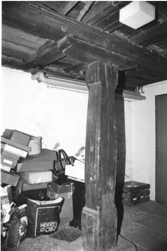
Balkendecke im Keller, mit gebauchter Eichenstütze (Bauernhausforschung 1988)
