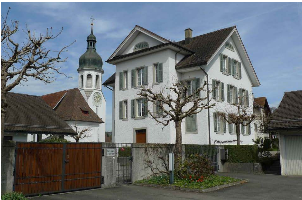
Ansicht von Süden, mit rückwärtigem Treppenhausrisalit (2016)
