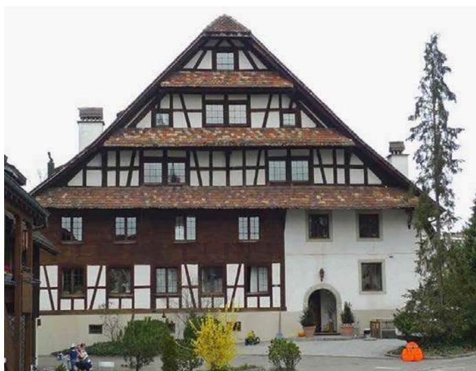
Ansicht südliche Schaufassade (2016)
