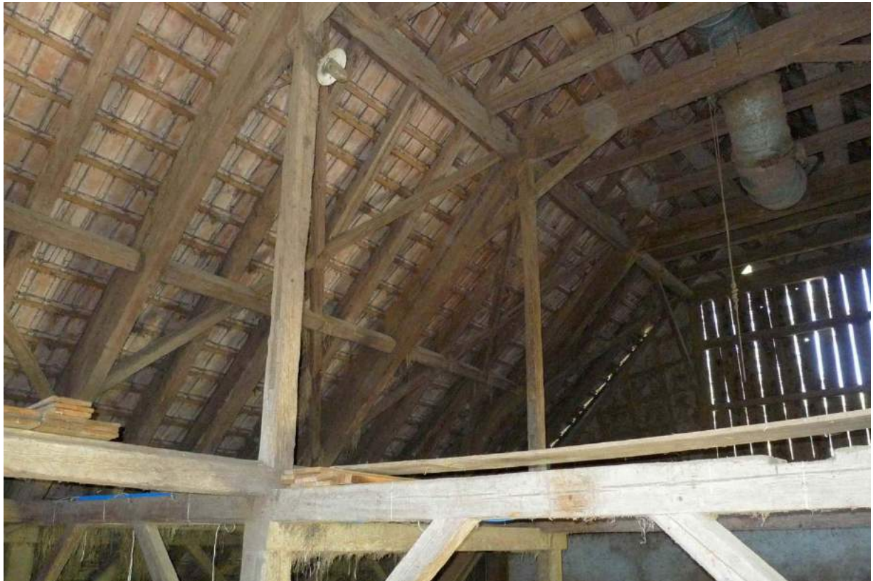
Ständergerüst und liegender Stuhl (2016)
