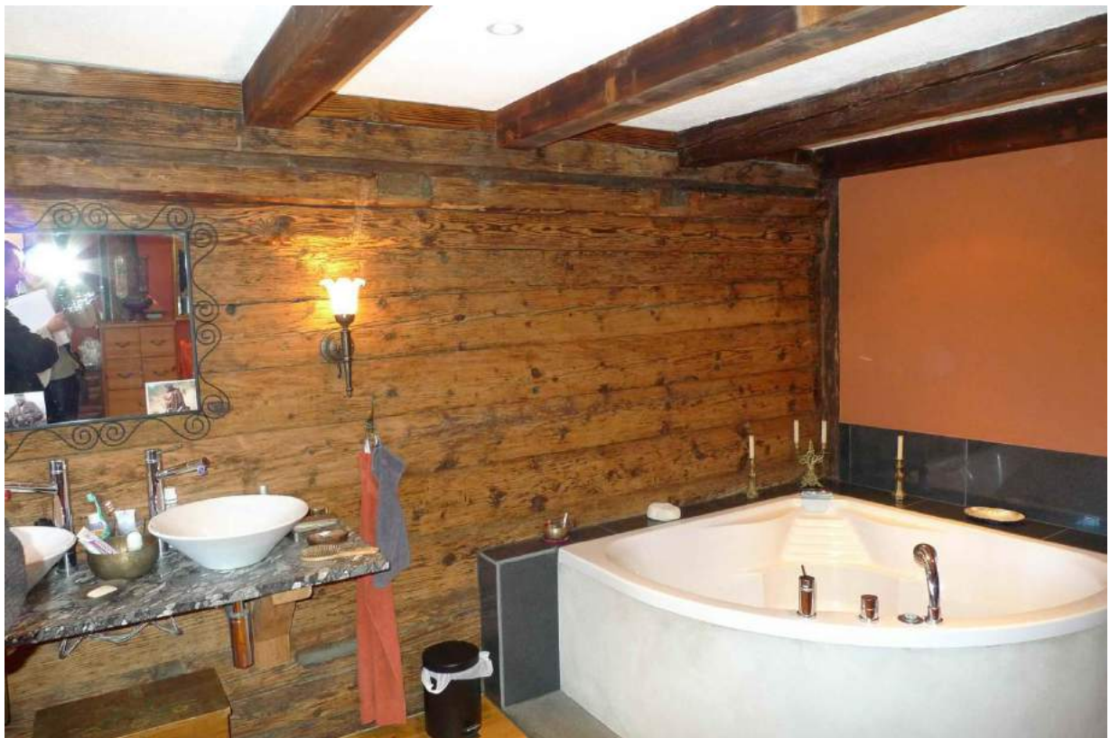
Alte Ständerwand im renovierten Hausteil Litz 10 (2016)
