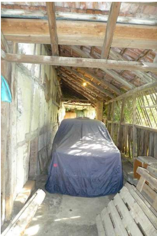
Traufseitiger Anbau entlang der Ostfassade (2016)
