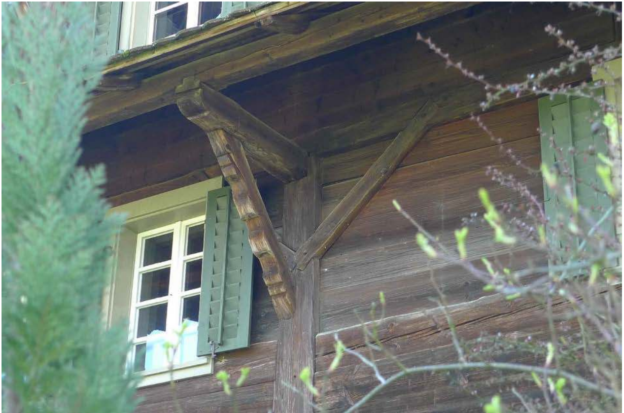
Fassadendetail mit verblatteten Kopfhölzern und karniesartig beschnitztem Bug (2016)
