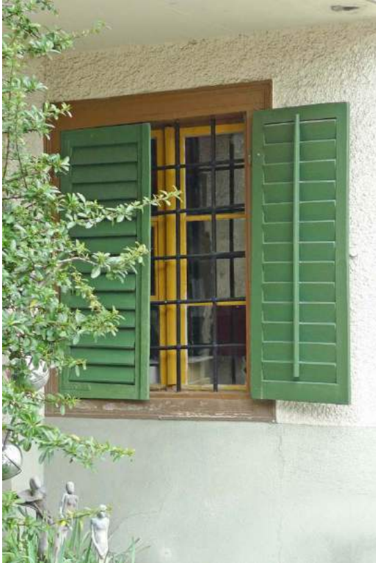
Fenster im EG des Kernbaus, Westfassade (2016)
