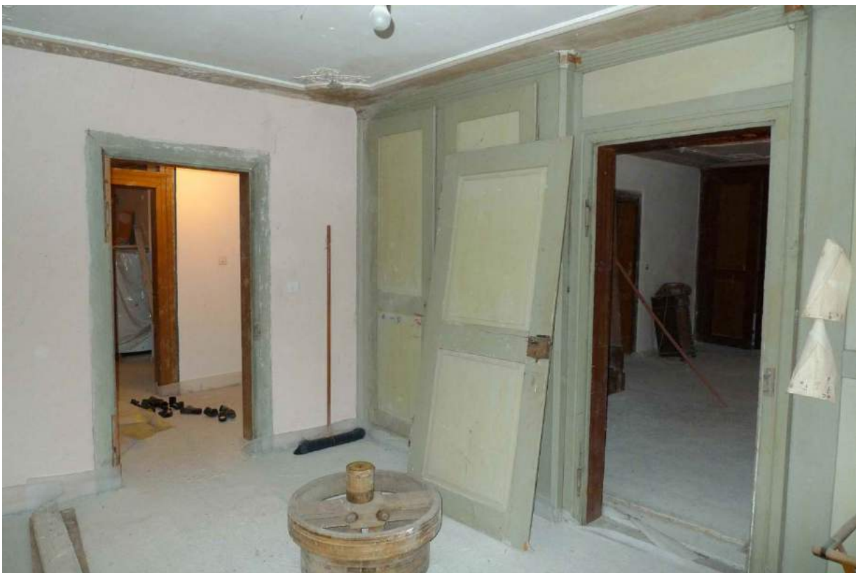
Raum mit Täfer und Stuckdecke im 3. OG (2016)
