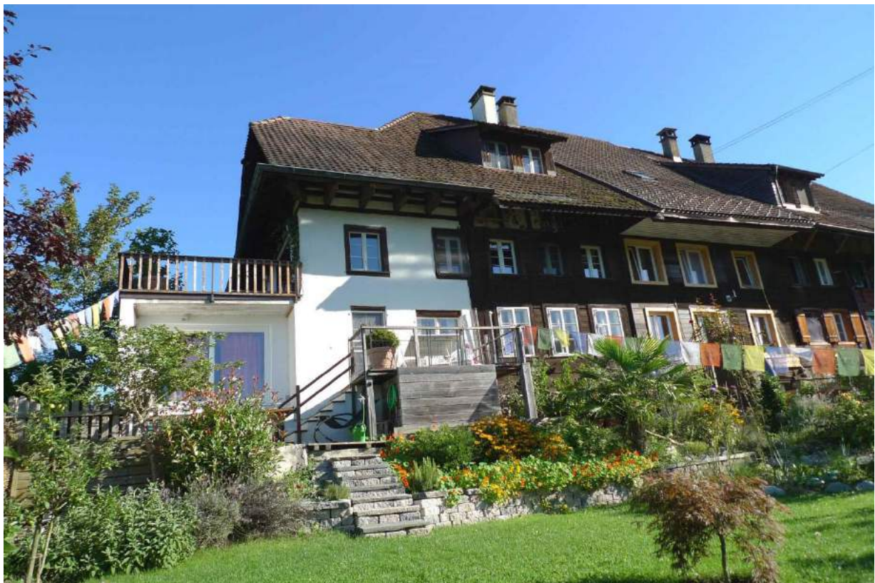
Südfassade westlicher Hausteil Litzi 10 (2016)
