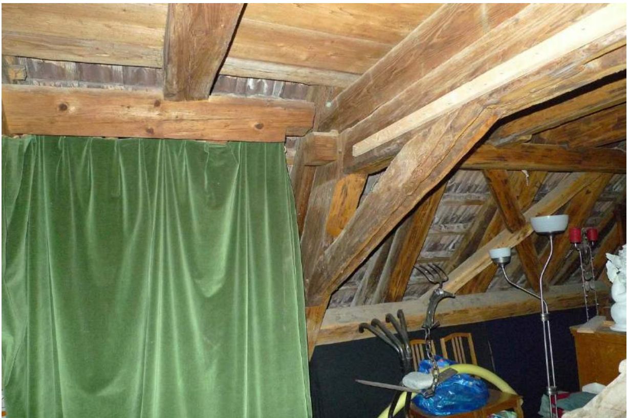
Dachgeschoss, angesetzte Dachkonstruktion von 1845 (2016)
