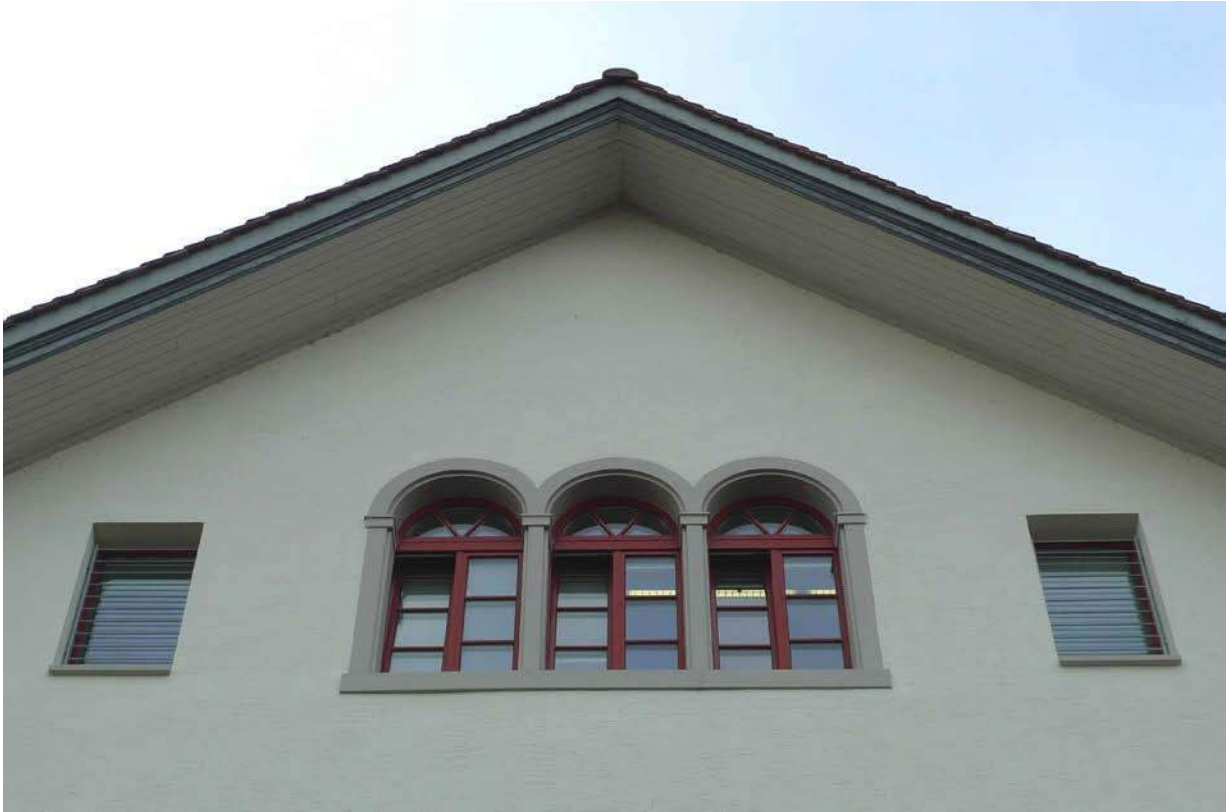
Dreiteiliges Rundbogenfenster im Giebelfeld (2016)
