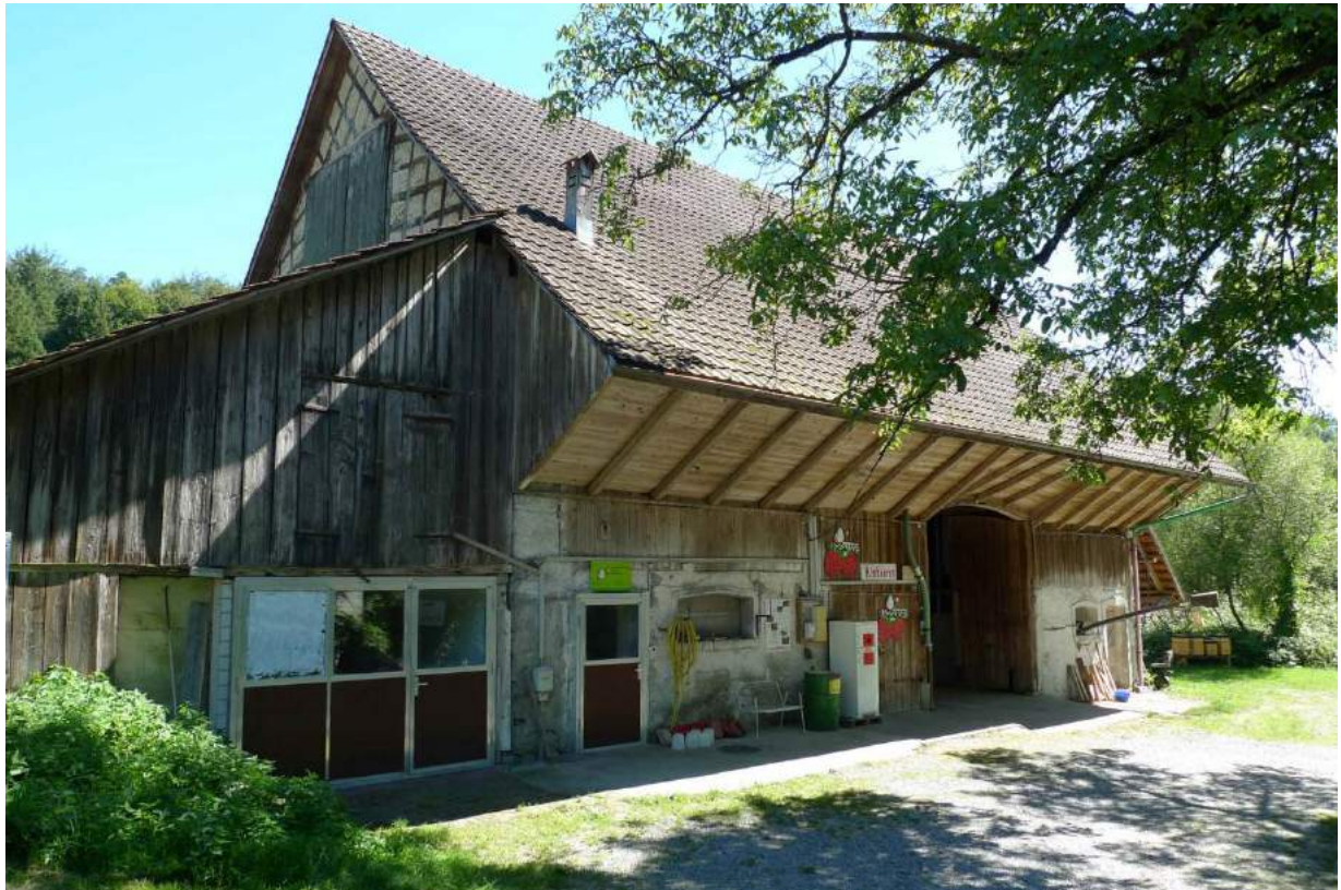
Blick von Nordwesten (2016)
