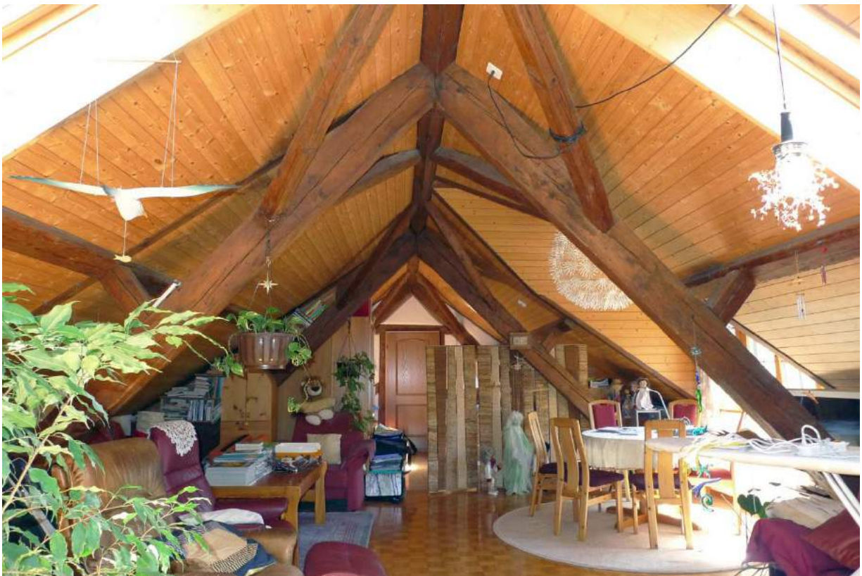
Westl. Hausteil, Dachkonstruktion des ehem. Speichers (2016)
