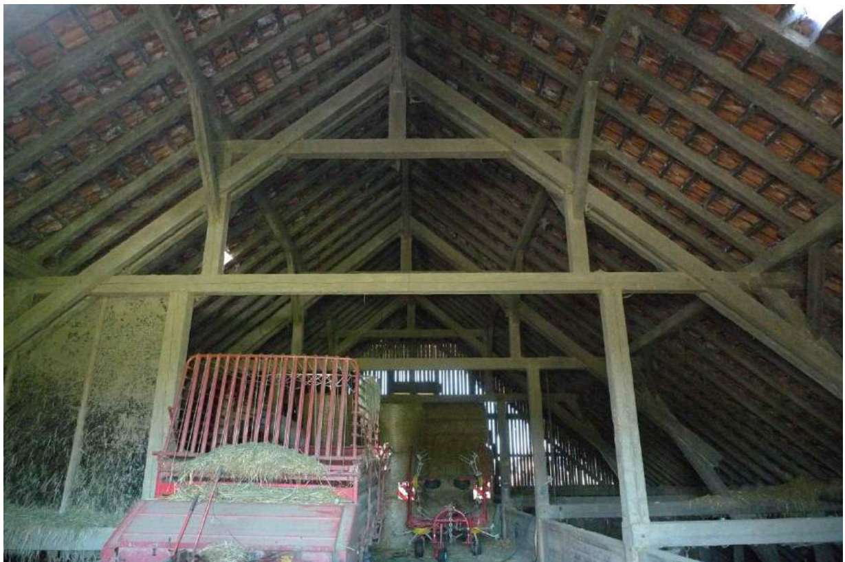
Dachkonstruktion von der Hocheinfahrt her gesehen (2016)
