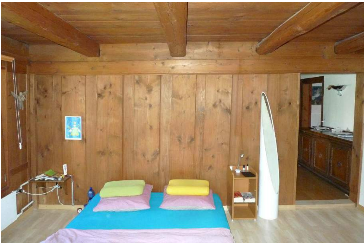
Nordöstlicher Hausteil, Wandtäfer im OG (2016)
