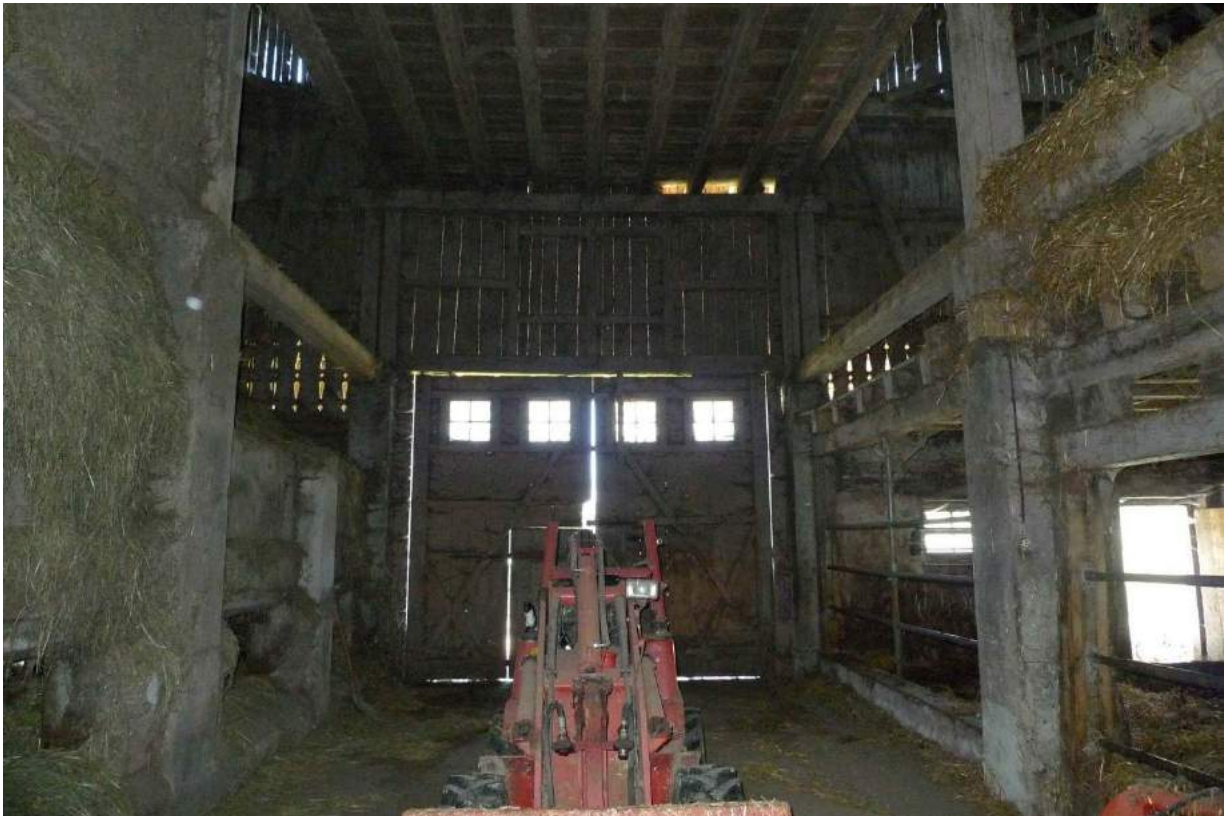
Tenneinfahrt, Blick nach Nordwesten (2016)
