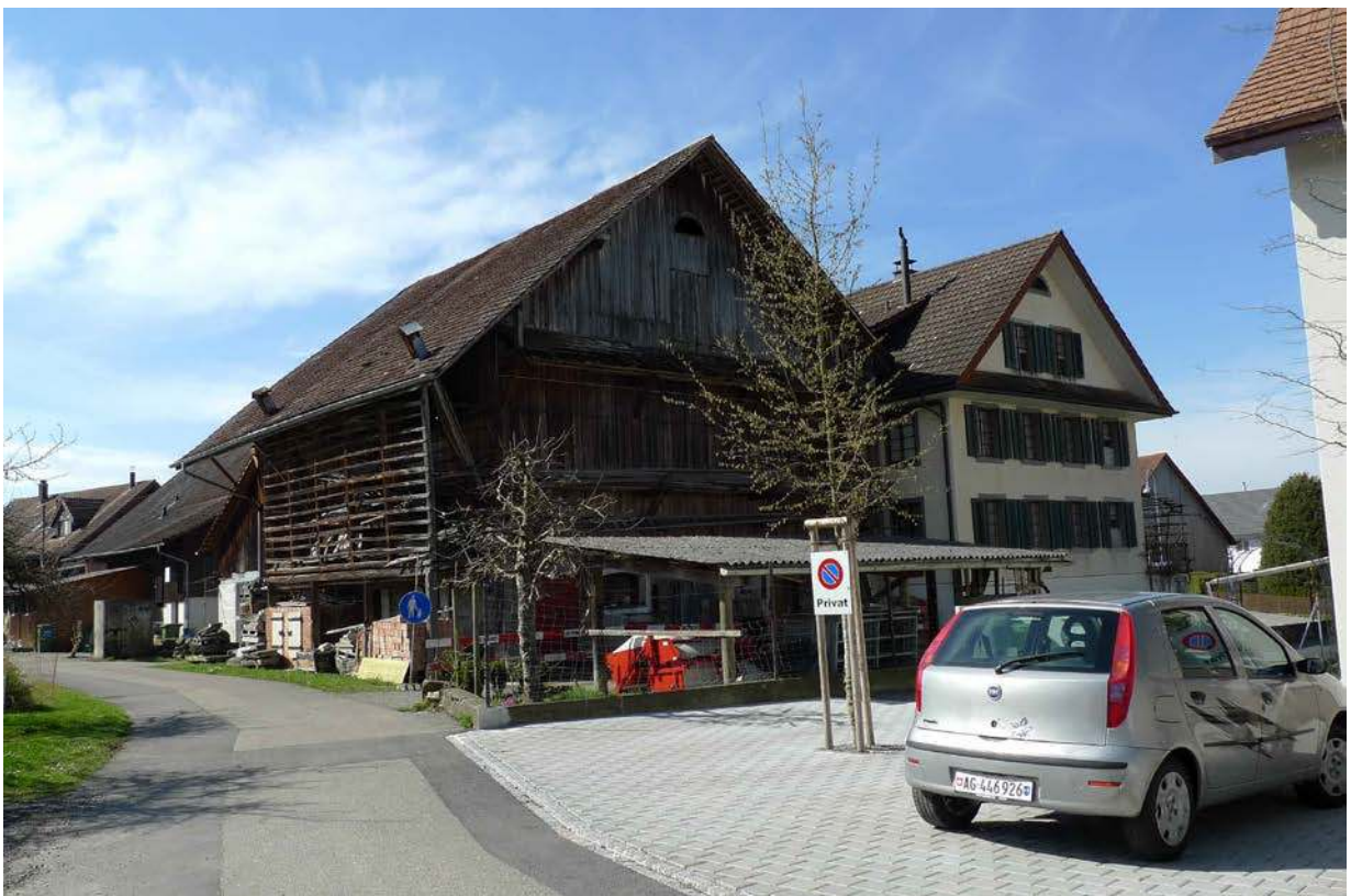
Gesamtansicht von Nordosten (2016)
