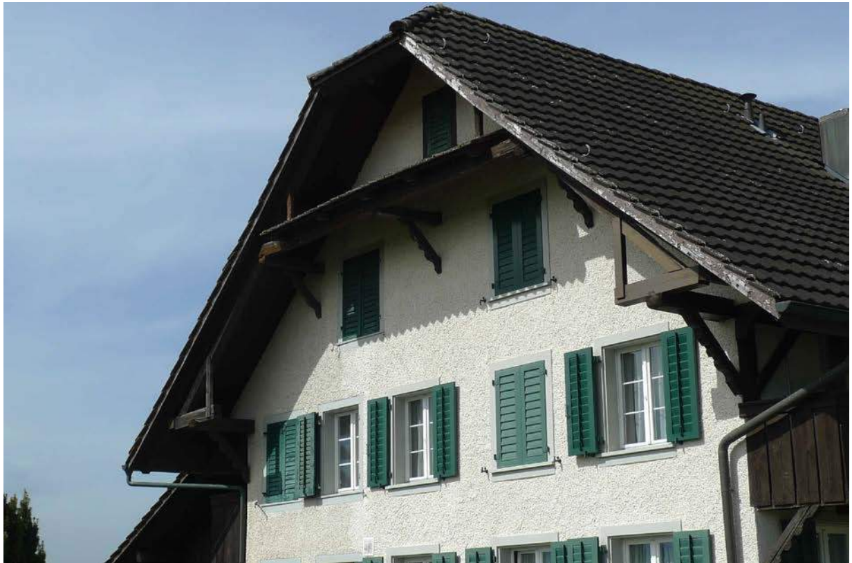
Giebelfeld mit Fluggespärre und Klebdächlein (2016)
