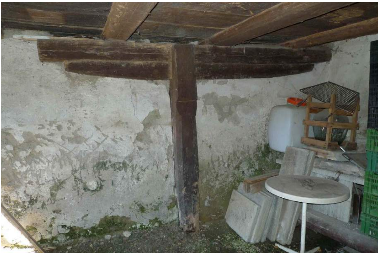
Deckenstütze Keller Litzi 16 (2016)
