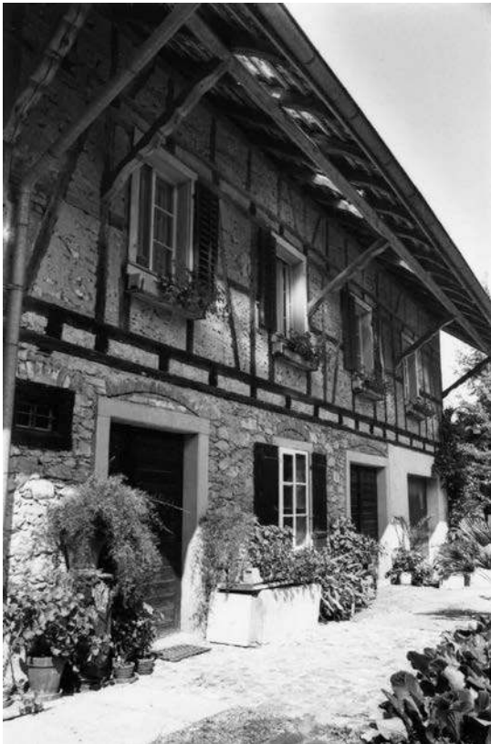
Südfassade des Ökonomiegebäudes von 1887 (Bauernhausforschung 1988)
