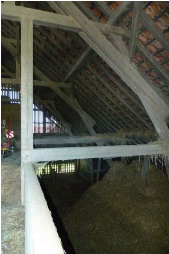
Dachkonstruktion, zangenartige Aussteifung (2016)
