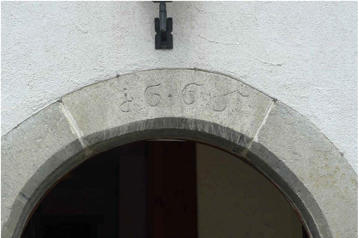
Baudatum 1665 am Mühleneingang (2016)
