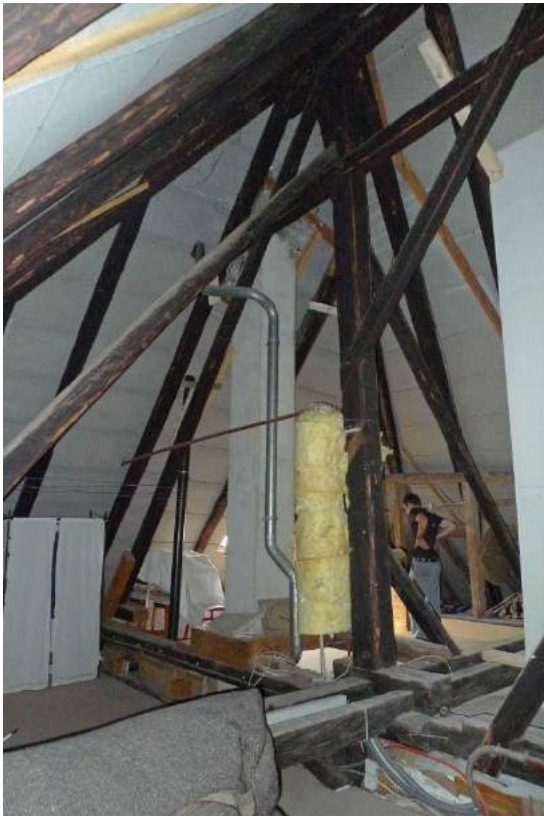
Südwestlicher Hausteil, dritter, nachträglich ergänzter Hochstud (2016)
