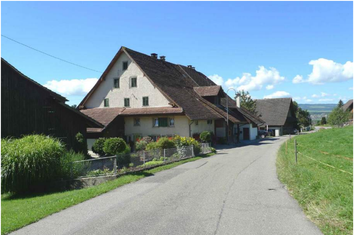
Situationsansicht von Nordosten (2016)
