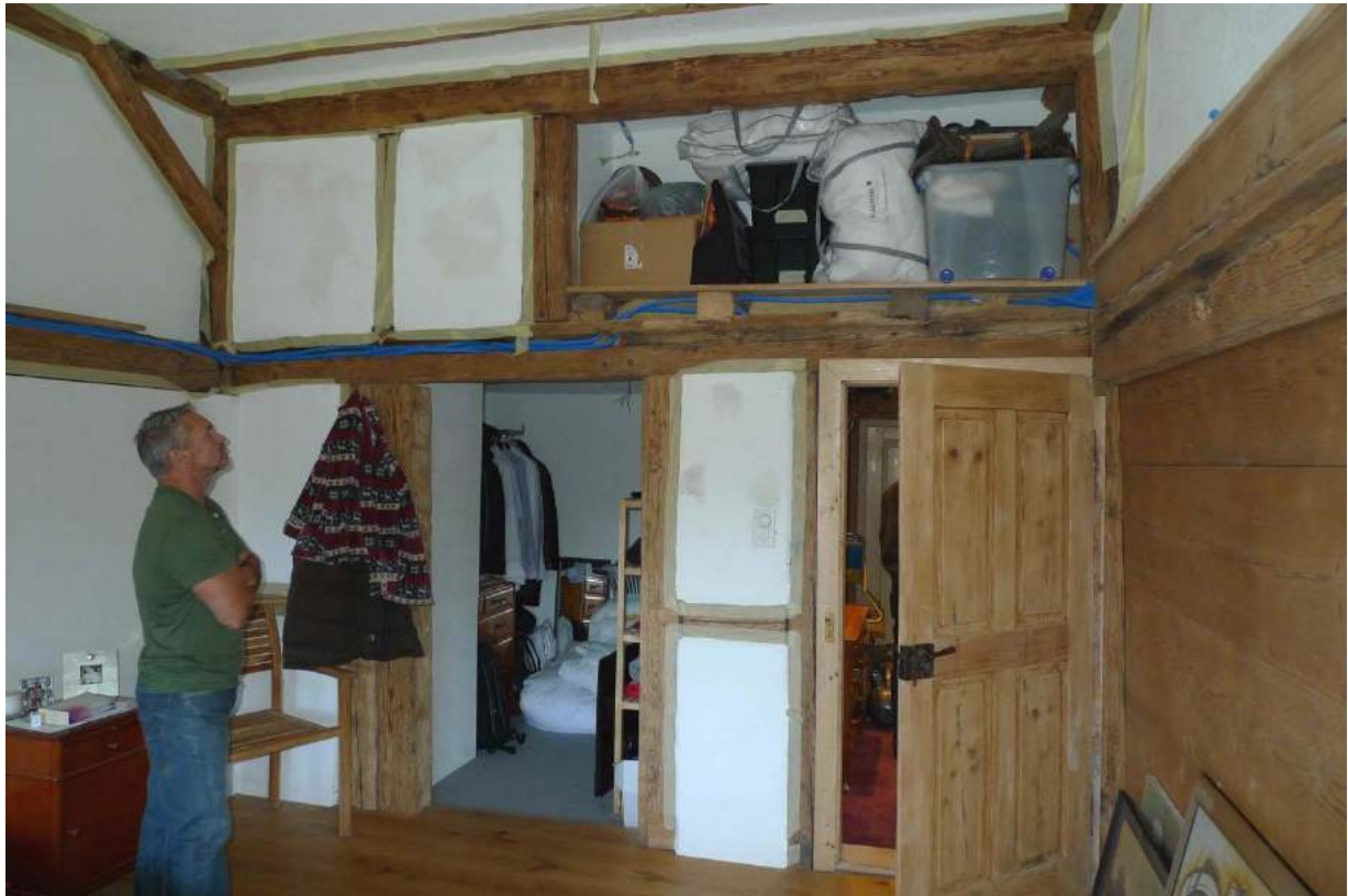
Angehobenes Deckenniveau im Obergeschoss Litzi 12 (2016)
