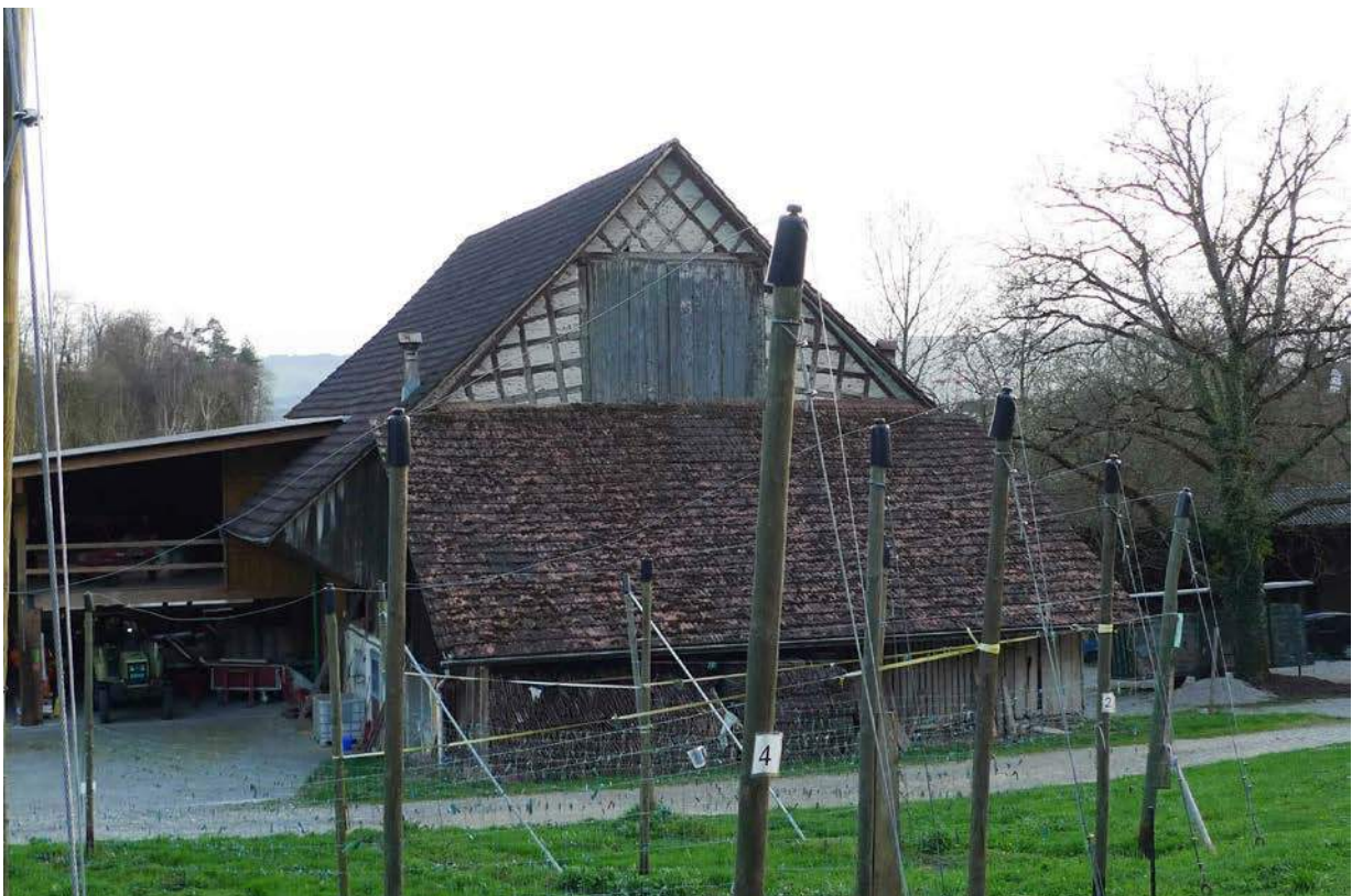
Ansicht von Norden (2016)
