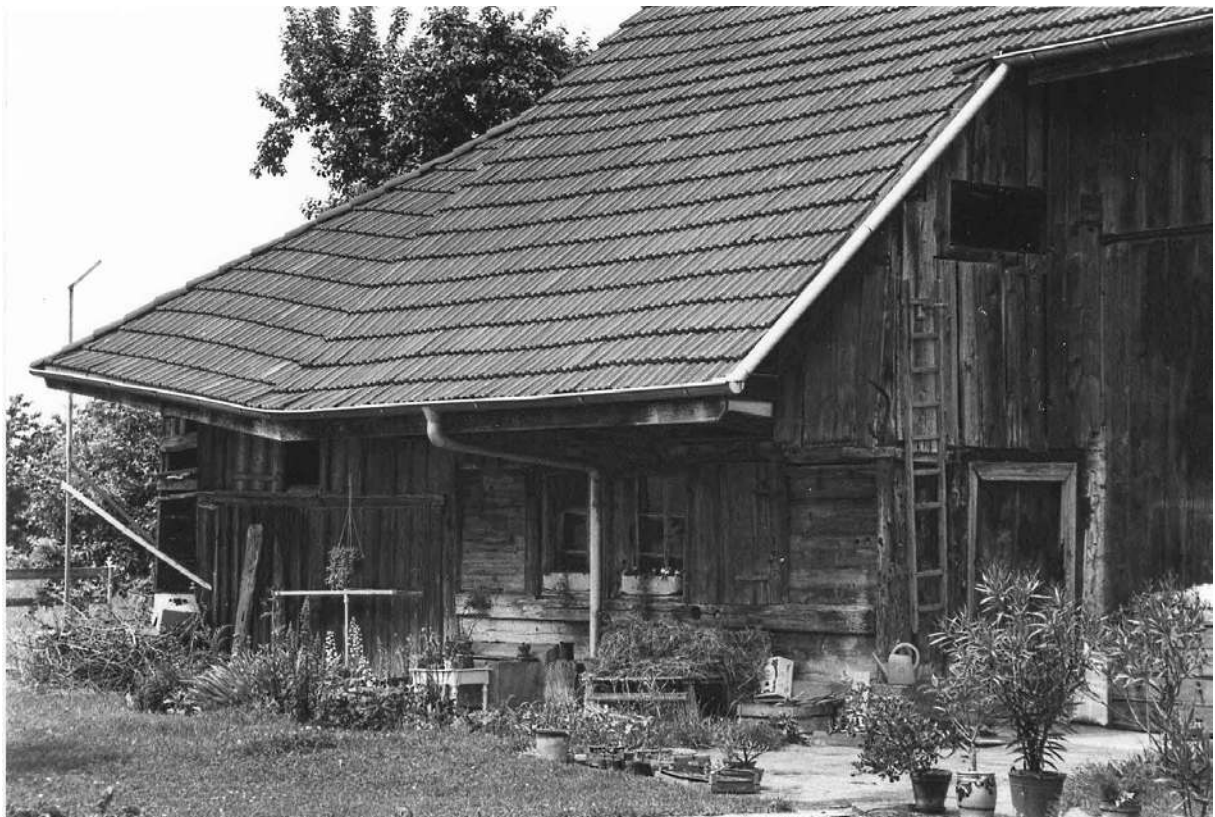
Südansicht Ökonomieteil (Bauernhausforschung 1988)
