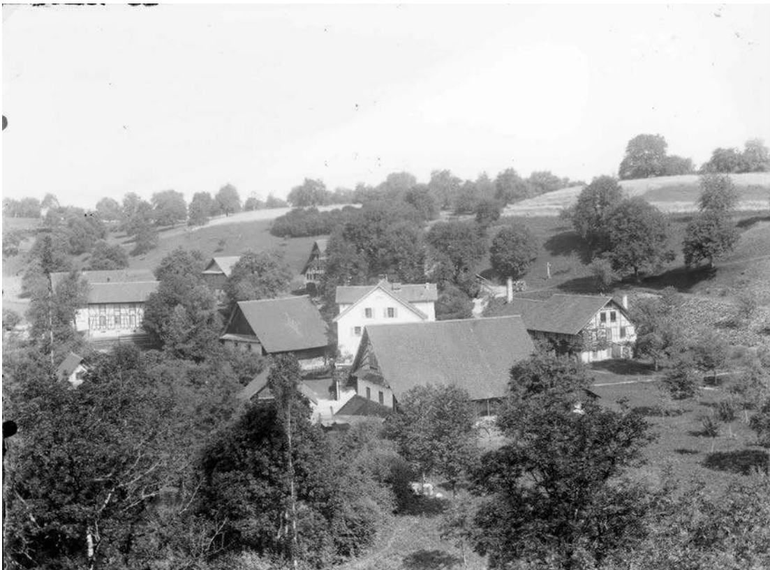
Baugruppe der Mühle Obschlagen, um 1900/20 (Fotosammlung Denkmalpflege)
