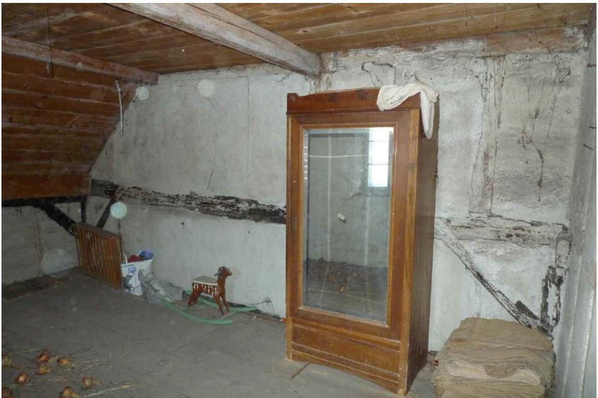
Zwischenwand mit altem Ständergerüst Litzi 16 (2016)
