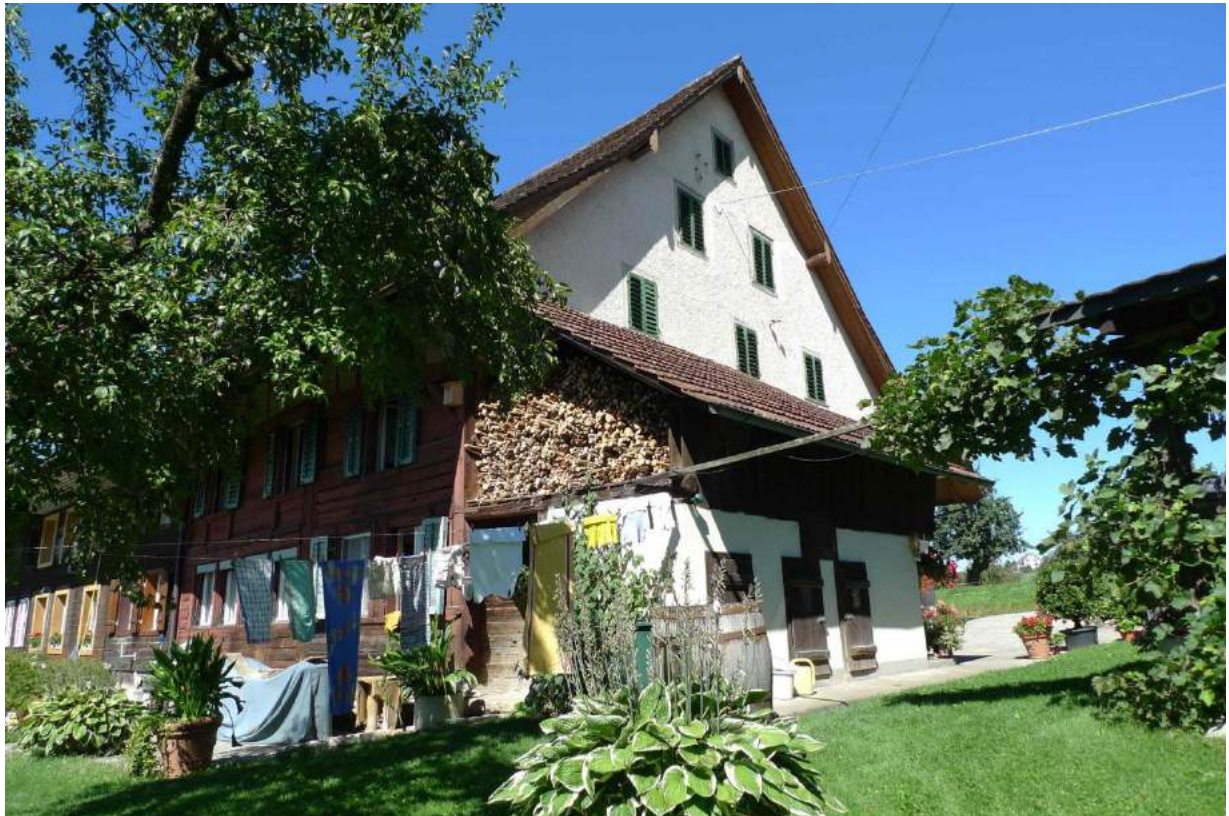
Ansicht von Südosten (2016)
