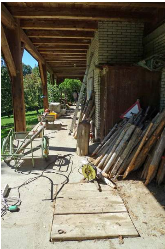
Südwestliche Traufseite, geschützter Aussenbereich (2016)
