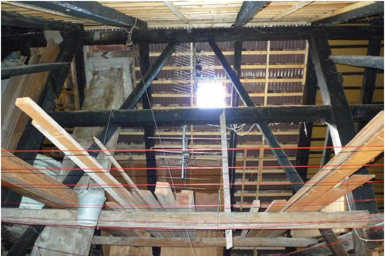
Hochstudkonstruktion Litzi 14 (2016)
