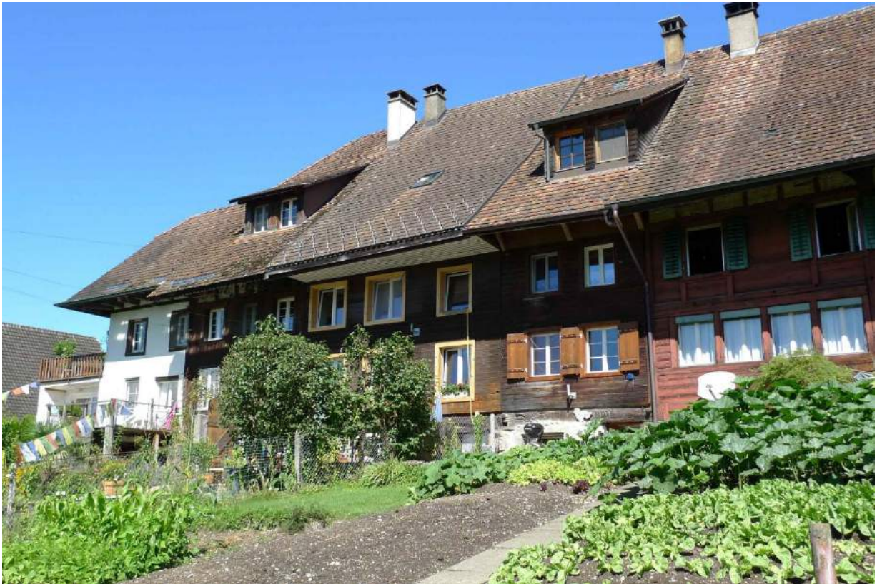
Südfassade, westliche Haushälfte (2016)
