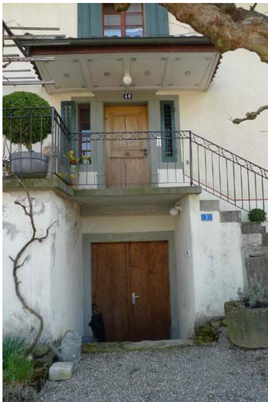
Westlicher Haus- und Kellereingang (2016)
