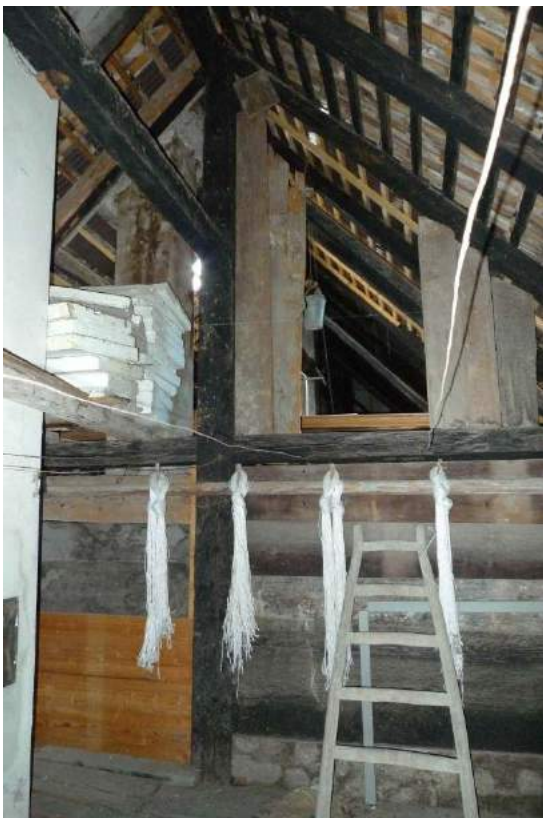
Hochstudkonstruktion Litzi 16 (2016)
