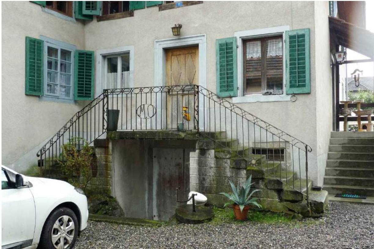
Hauseingang der westl. Haushälfte, Erweiterung um 1850 (2016)
