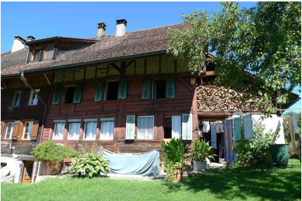
Südfassade, östliche Haushälfte (2016)
