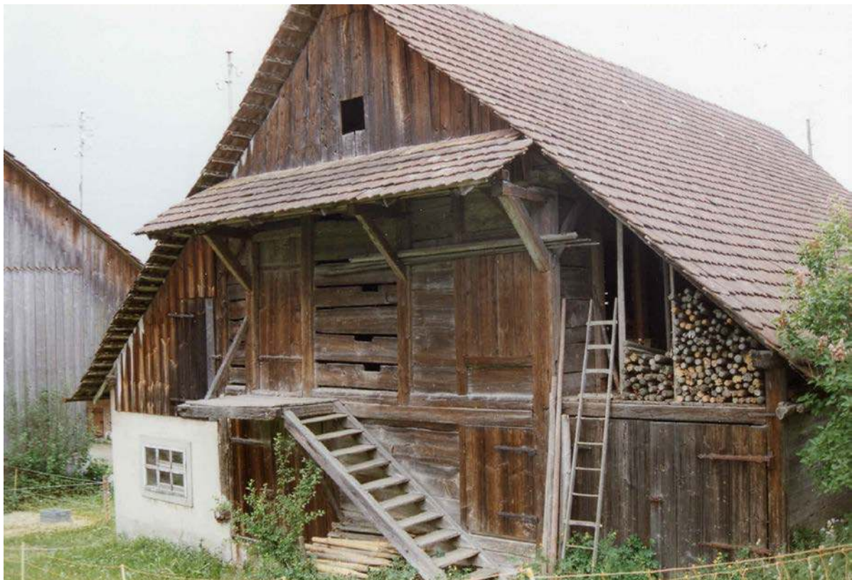
Nordostansicht Trottenteil (Kurzinventar 1998)
