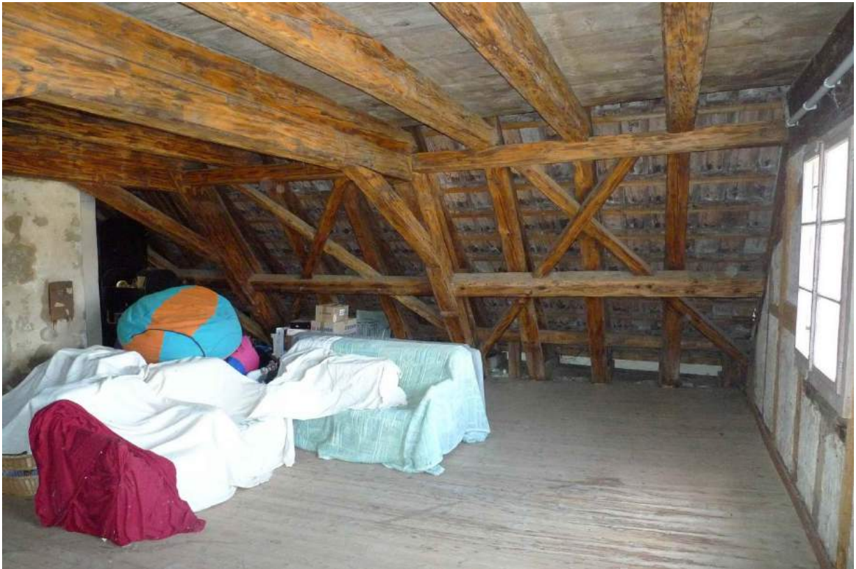
Dachkonstruktion mit Andreaskreuzen, um 1750 (2016)
