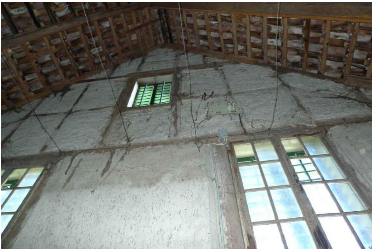
Innenansicht Giebelwand Litzi 16 (2016)
