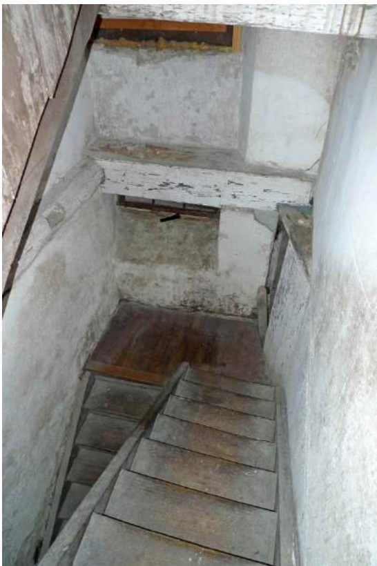
Treppe vom EG in den Keller, westl. Hausteil (2016)
