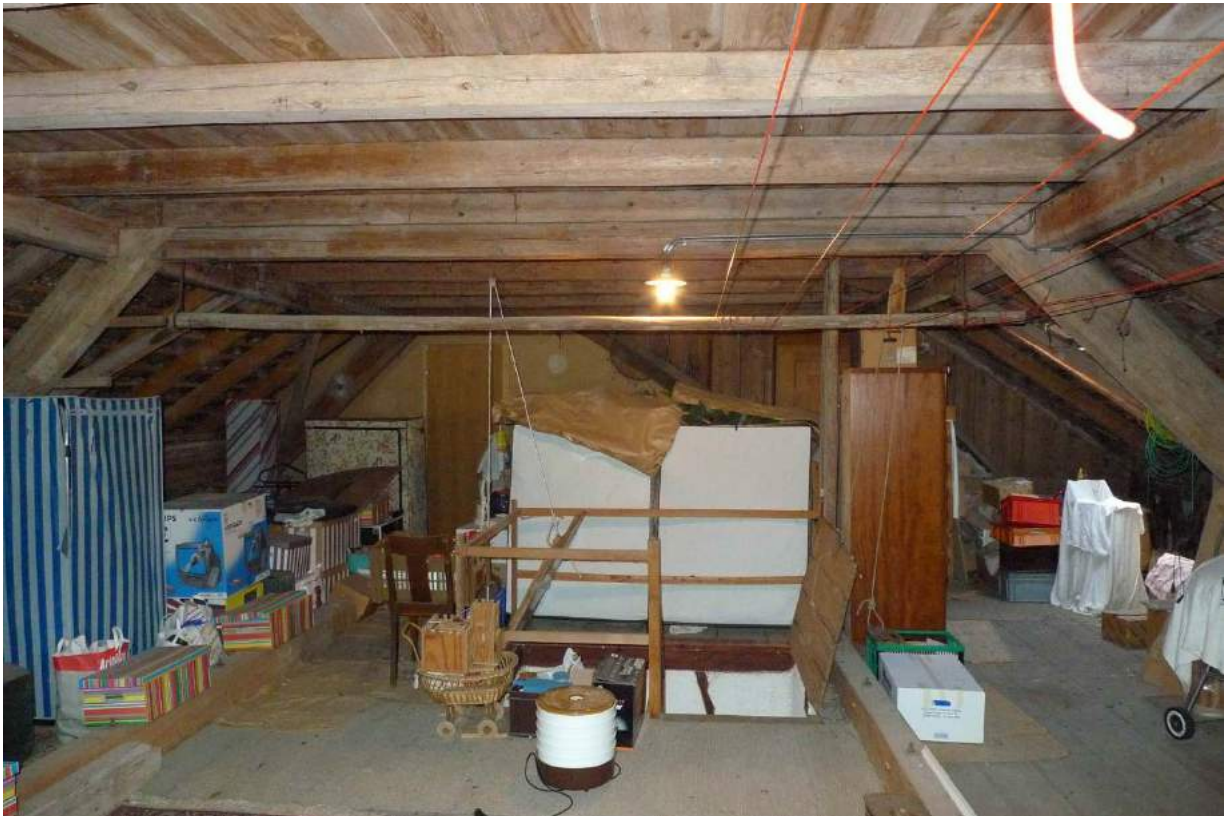
DG mit liegendem Stuhl, östlicher Hausteil von 1887 (2016)
