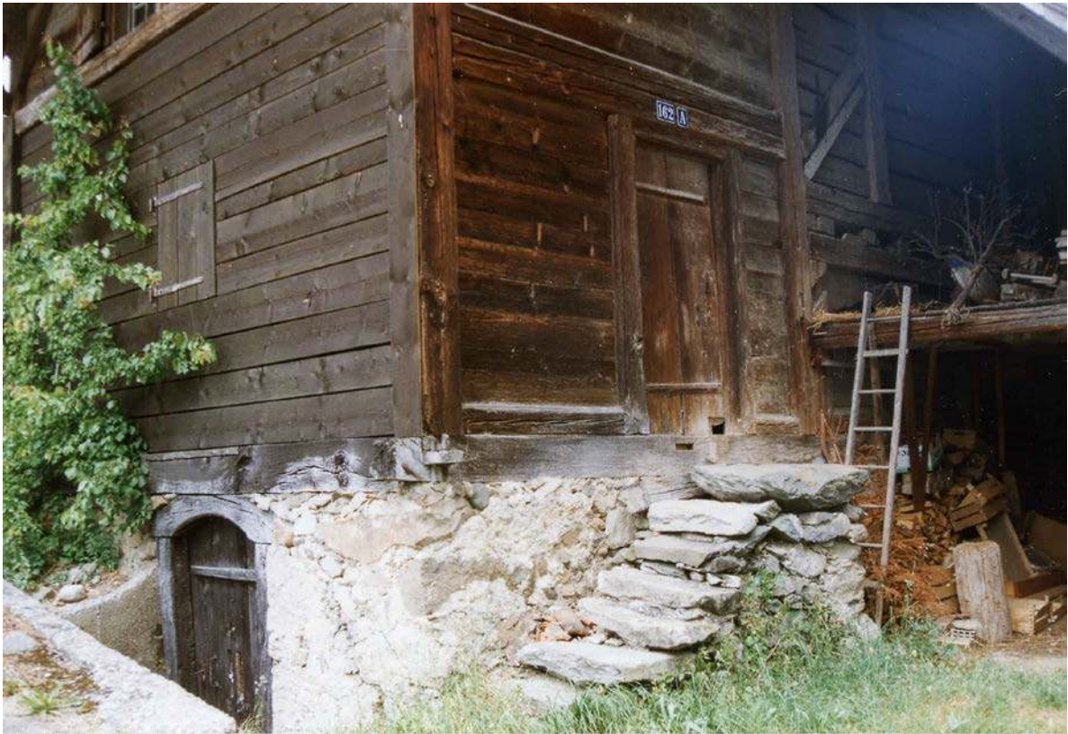
Ansicht Speicherteil von Südwesten (2016)
