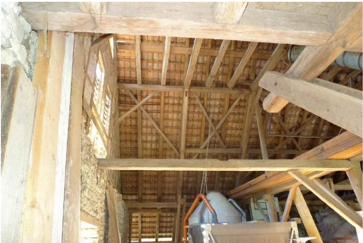
Dachkonstruktion mit Andreaskreuzen (2016)
