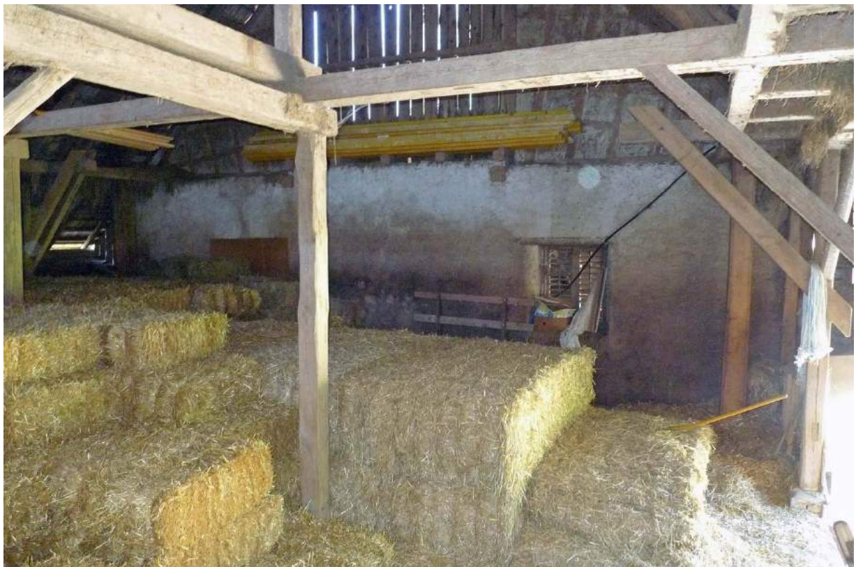
Innenansicht der nördlichen Giebelmauer (2016)
