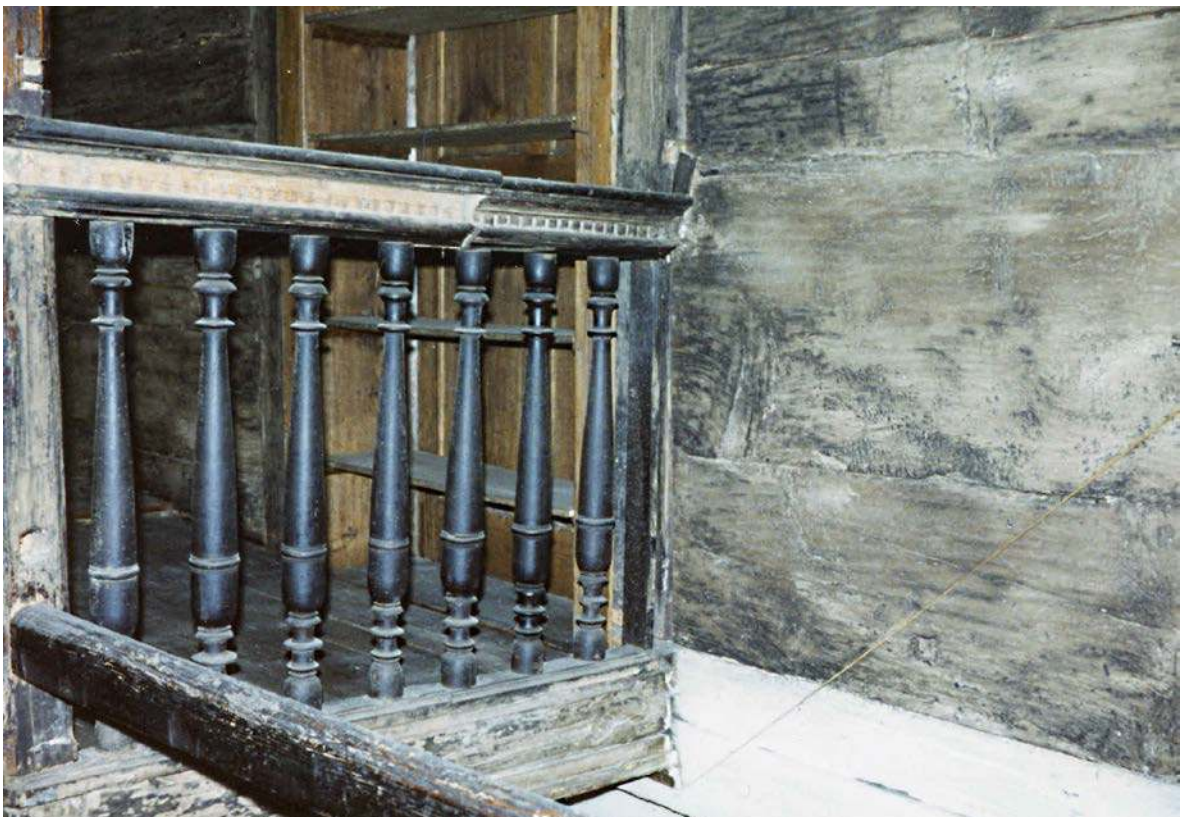
Treppenaufgang, Vorrenovationszustand (Fotoarchiv Denkmalpflege 1984)
