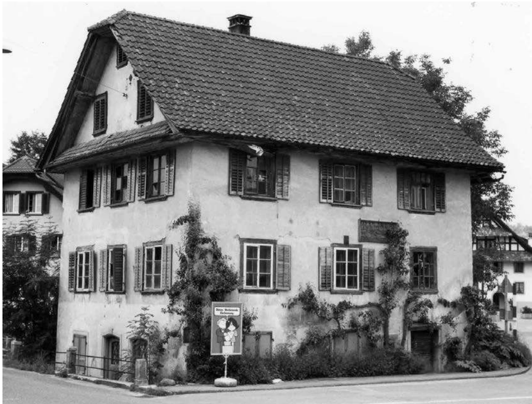
Frühere Verhältnisse mit noch bestehenden westseitigen Tür- und Fensteröffnungen im Sockelgeschoss (Foto Bauernhausforschung 1988)
