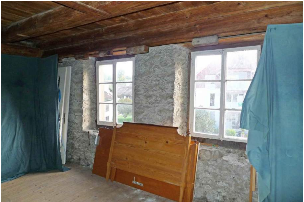
DG, nördliche Stirnmauer von 1845 (2016)
