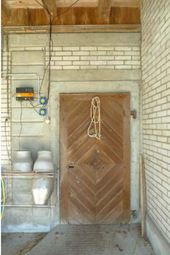
Stalleingang südwestliche Traufseite (2016)
