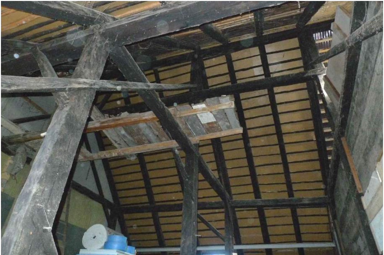
Hochstudkonstruktion Litzi 12 (2016)
