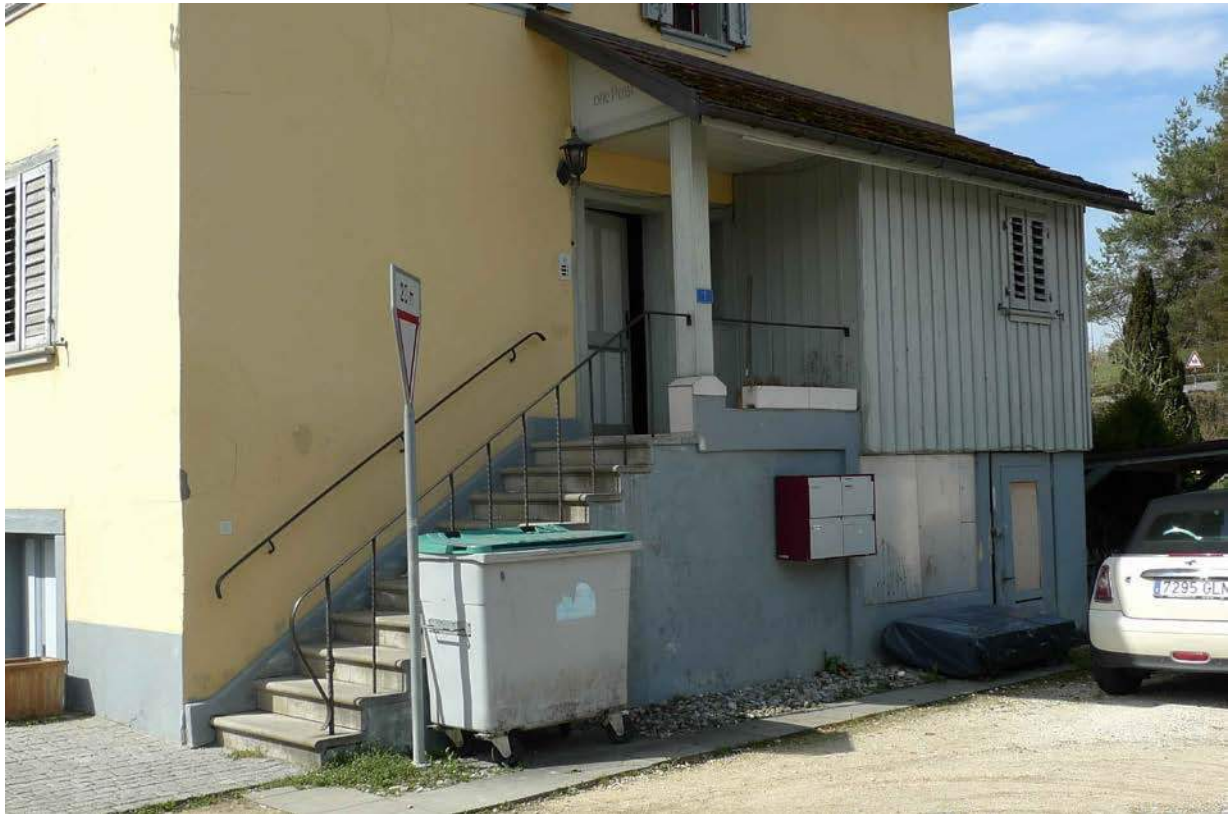
Eingangssituation östliche Stirnseite (2016)
