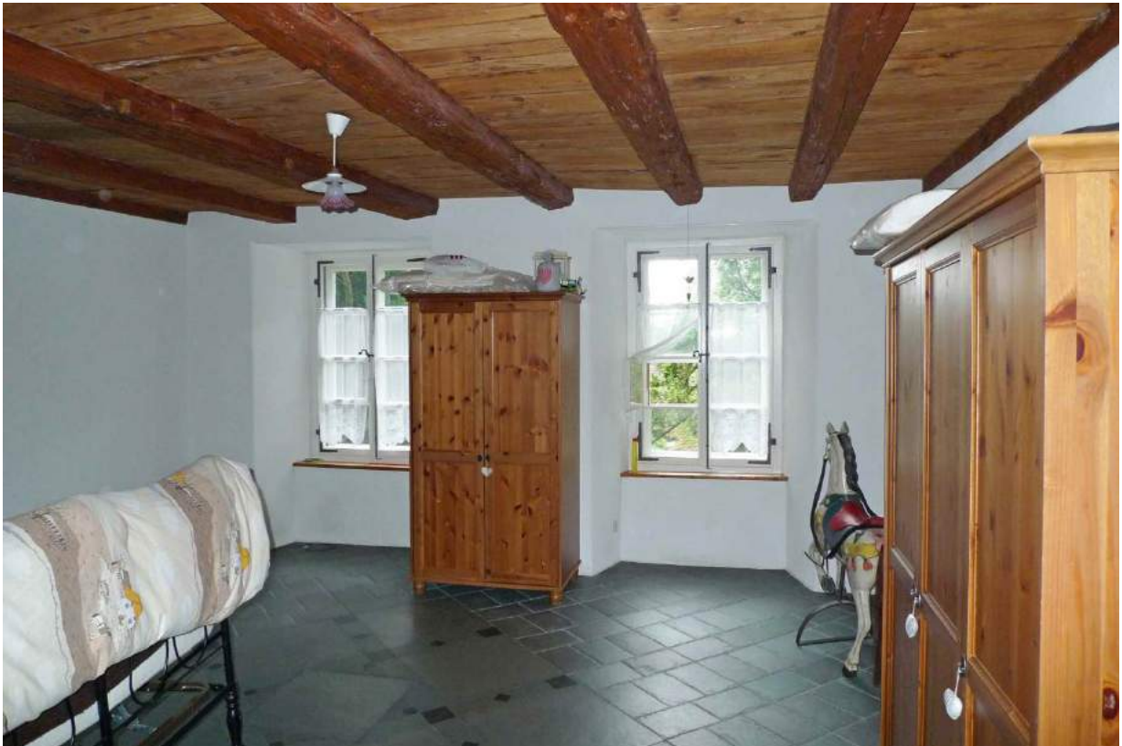
Zimmer mit Sichtbalkendecke im 2. OG (2016)
