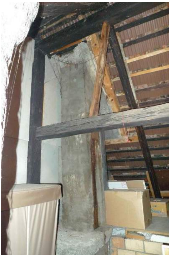
Hochstudkonstruktion (2016)
