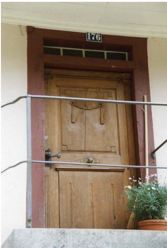
Hauseingang mit bauzeitlichem beschnitztem Türblatt (Kurzinventar 1998)
