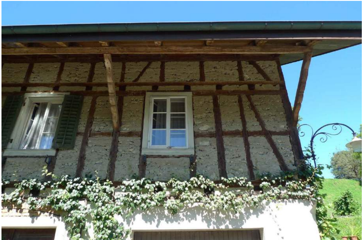
Ausschnitt südl. Fachwerkwand des Hausteils von 1887 (2016)
