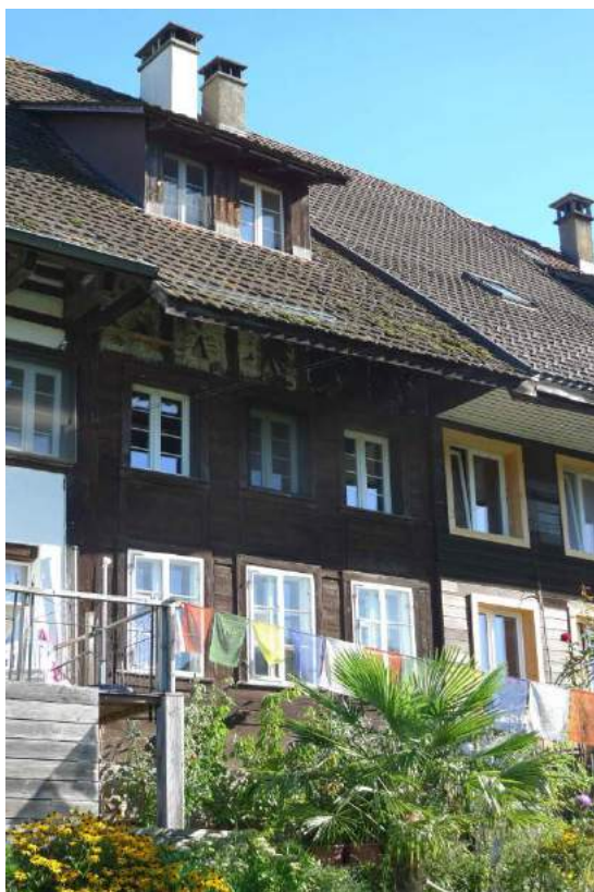
Hölzerne Südfassade Hausteil Litzi 12 (2016)
