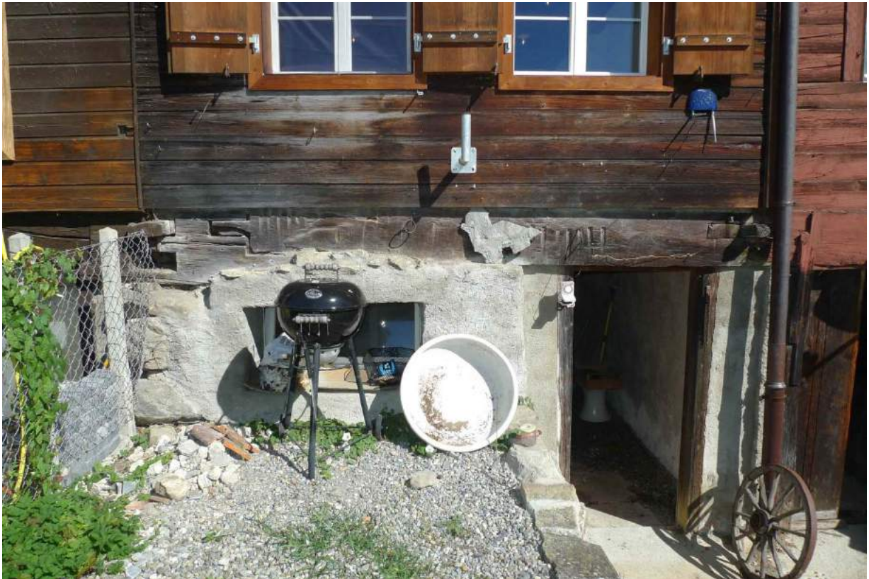
Eichenschwelle Südfassade Litzi 14 (2016)
