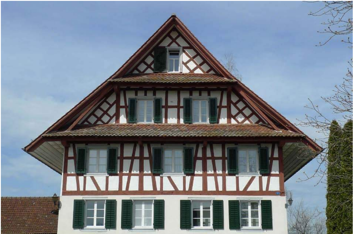
Sichtfachwerk südliche Giebelfront (2016)
