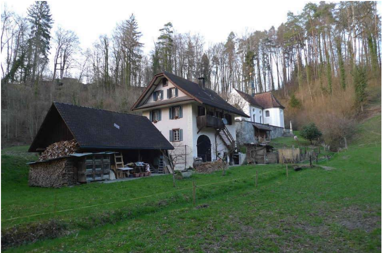
Situationsansicht von Südwesten (2016)
