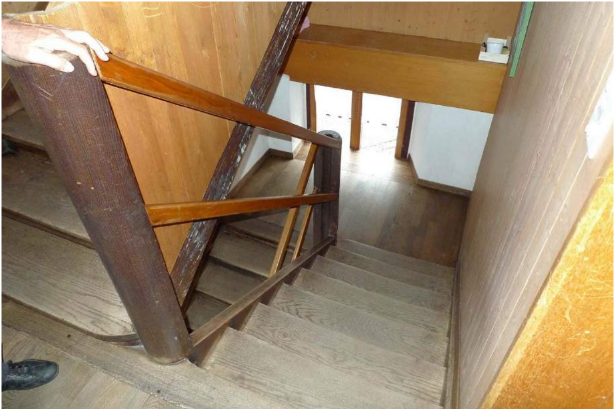
Treppenhaus westl. Hausteil, um 1850 (2016)
