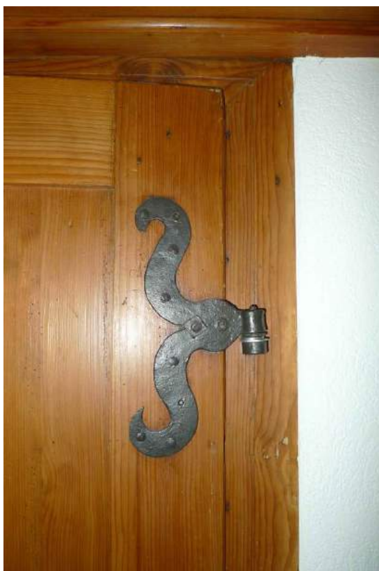
S-Band an Tür des Südostzimmers, nördlicher Hausteil (2016)
