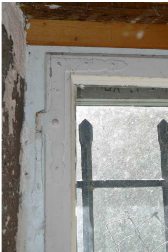
Ehem. Bäckerei, Fensterbeschläge aus der 1. Hälfte/ Mitte des 19. Jh. (2016)
