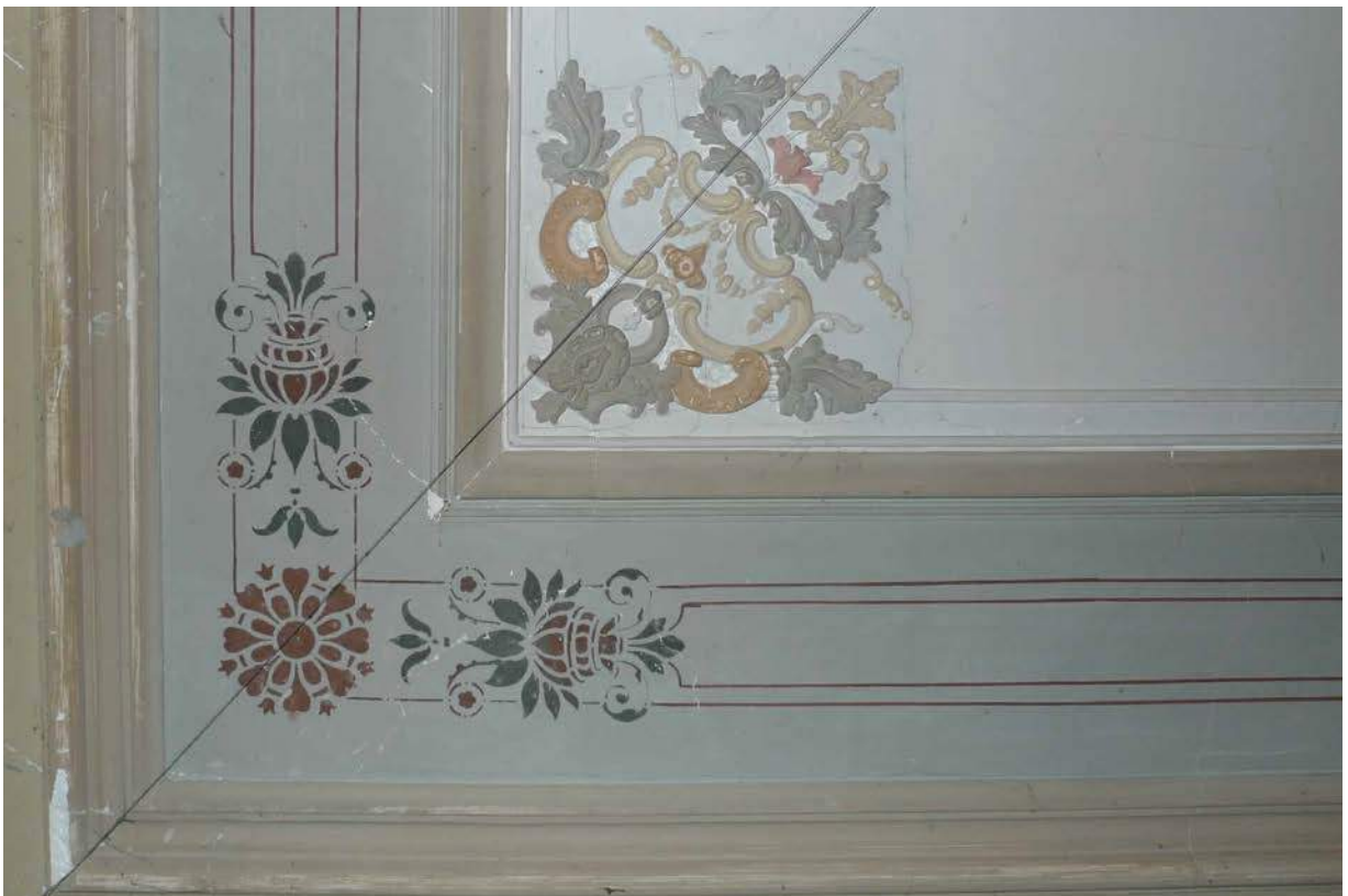
Decke mit Stuck und Schablonenmalerei, 3. OG (2016)
