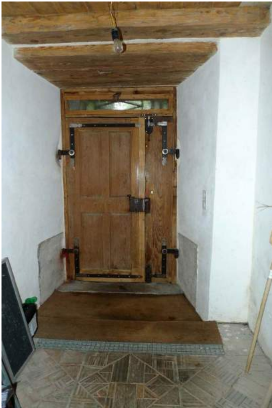
Westlicher Vordereingang zum alten Wohnteil (2016)
