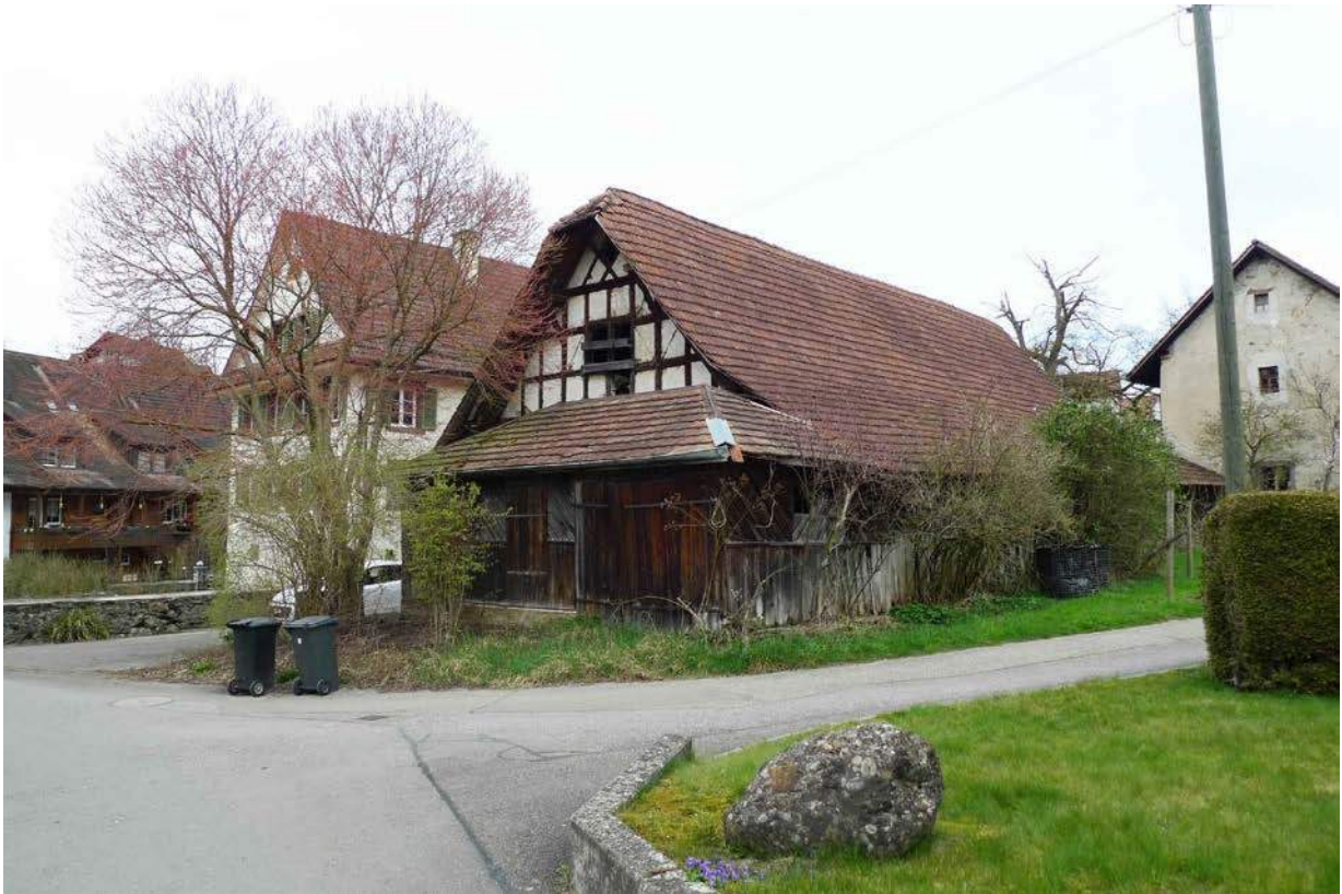
Baugruppe mit „Löwen“, Trotte und Speicher von Süden (2016)
