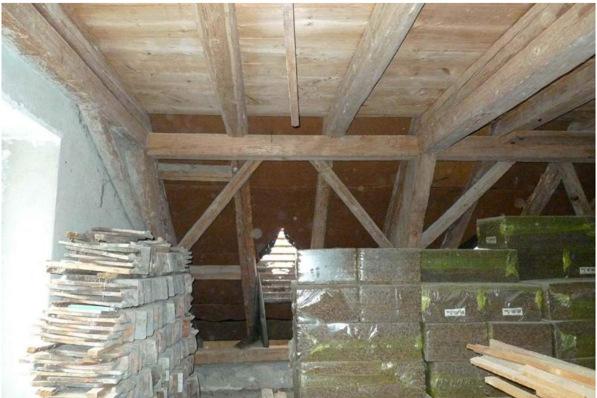
Dachkonstruktion, unteres DG (2016)
