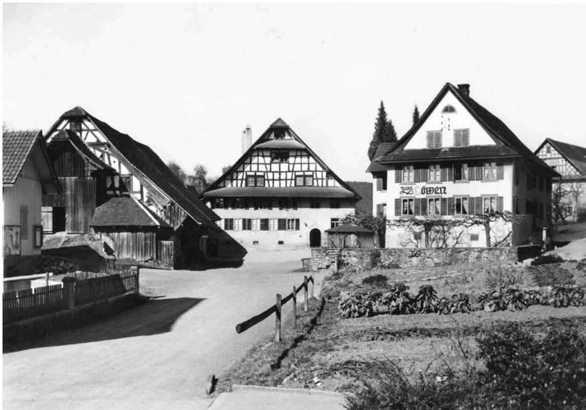
Situationsansicht von Süden, Zustand 1961 (Fotoarchiv Denkmalpflege)
