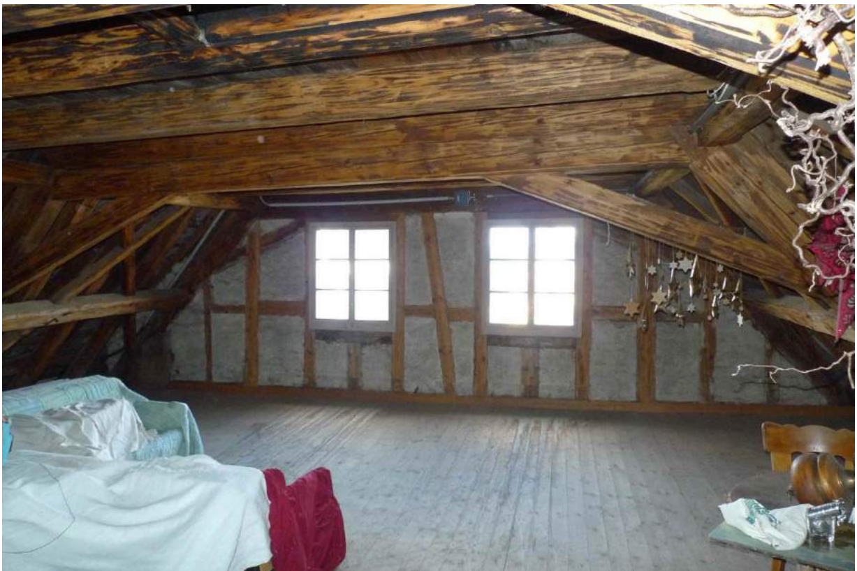
Dachkonstruktion im Kernbau mit liegendem Stuhl (2016)
