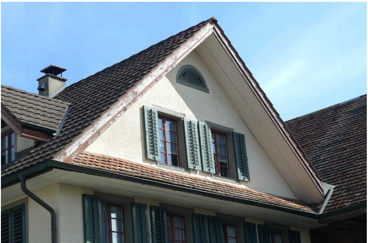
Detail südliches Giebelfeld (2016)
