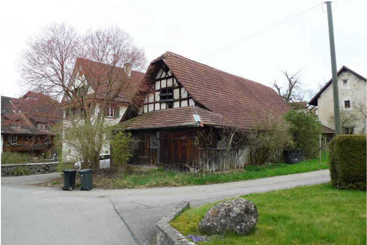
Baugruppe mit „Löwen“, Trotte und Speicher (2016)
