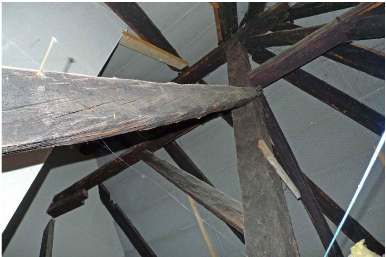
Südwestlicher Hausteil, angesetzte Hochstudkonstruktion (2016)
