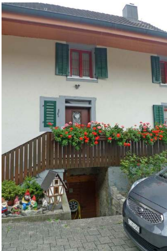
Hauseingang der östlichen Haushälfte (2016)
