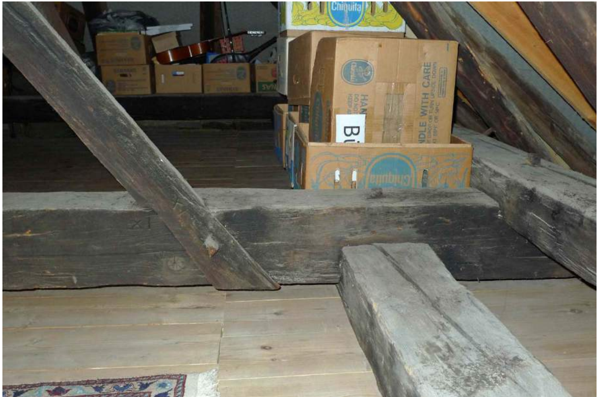
Nordöstlicher Hausteil, Balkengerüst im DG (2016)
