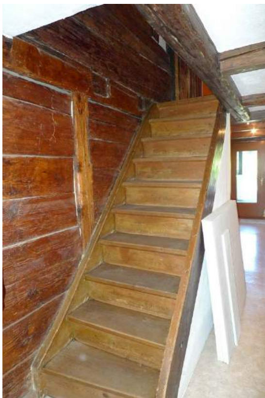
Hölzerne Treppe Litzli 14 (2016)
