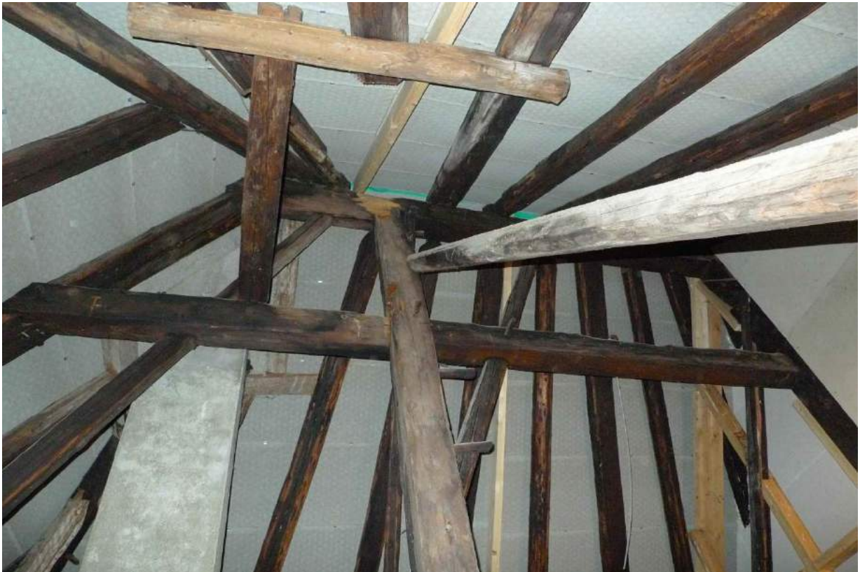
Nordöstlicher Hausteil, Hochstudkonstruktion (2016)
