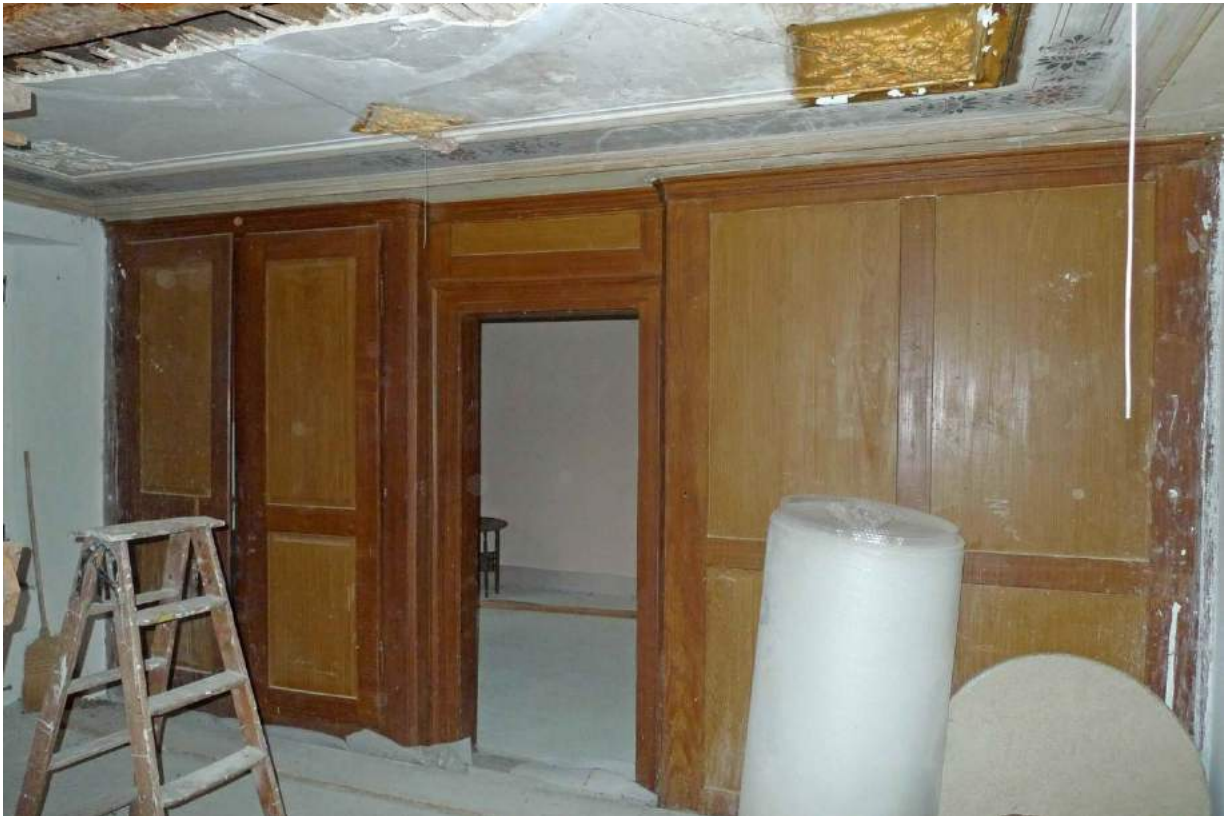
Raum mit Täfer und Stuckdecke im 3. OG (2016)
