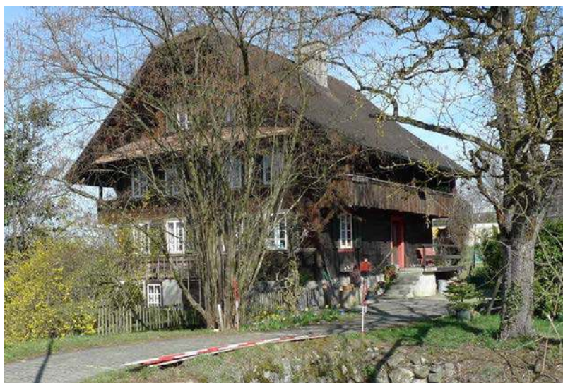
Ansicht von Südosten (2016)
