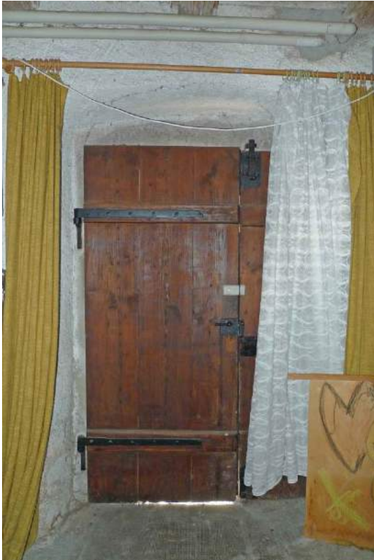
Bretttertür am Ökonomiegebäude von 1887 (2016)
