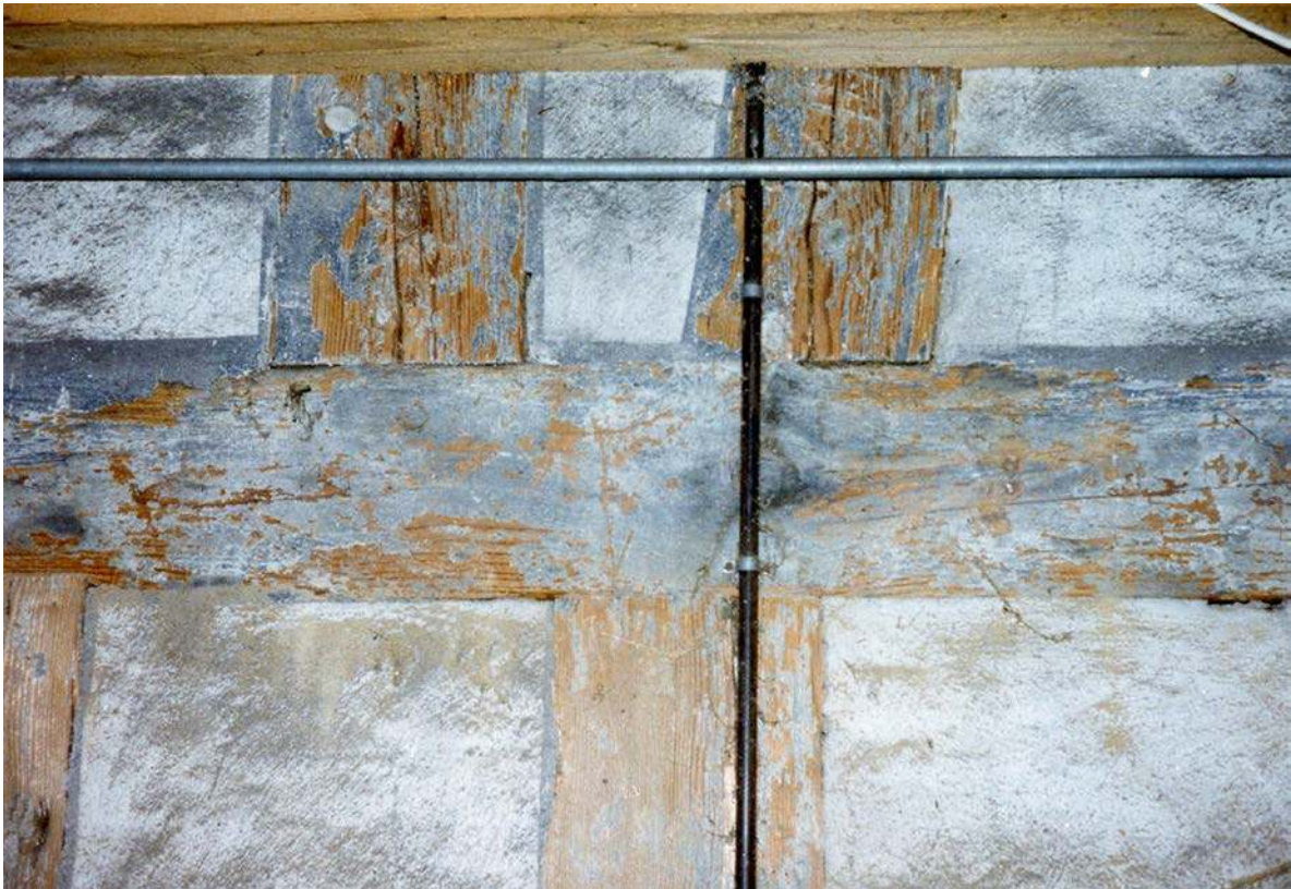
Fachwerk Hausinneres, Vorrenovationszustand (Fotoarchiv Denkmalpflege 1984)
