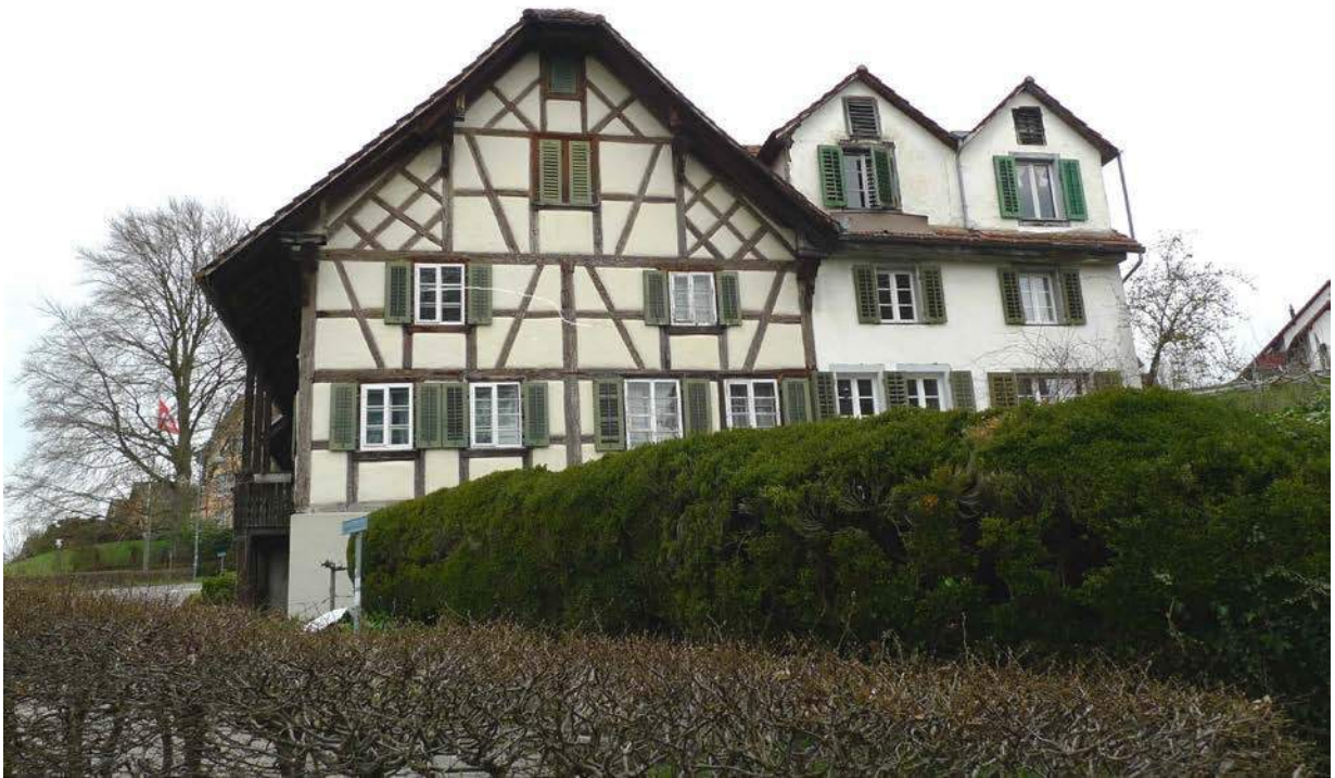
Ansicht von Südosten, mit Fachwerk-Kernbau und rückwärtiger Erweiterung (2016)
