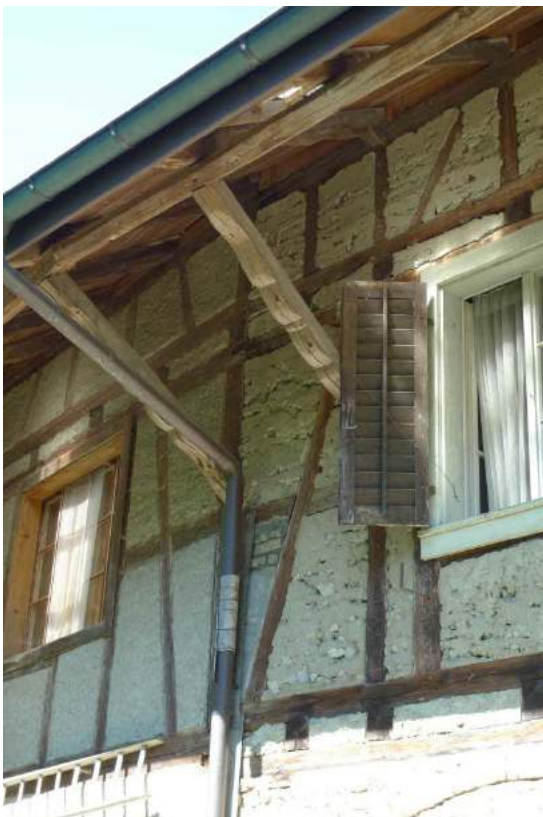
Übergang Fachwerkwand westl./östl. Hausteil (2016)
