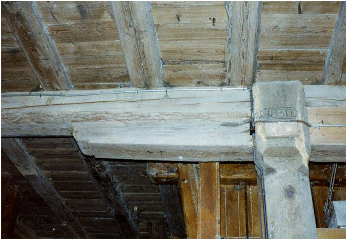
Umbaudatum 1830 an Stützpfiler im Keller nördlicher Erweiterungsbau (Kurzinventar 1998)
