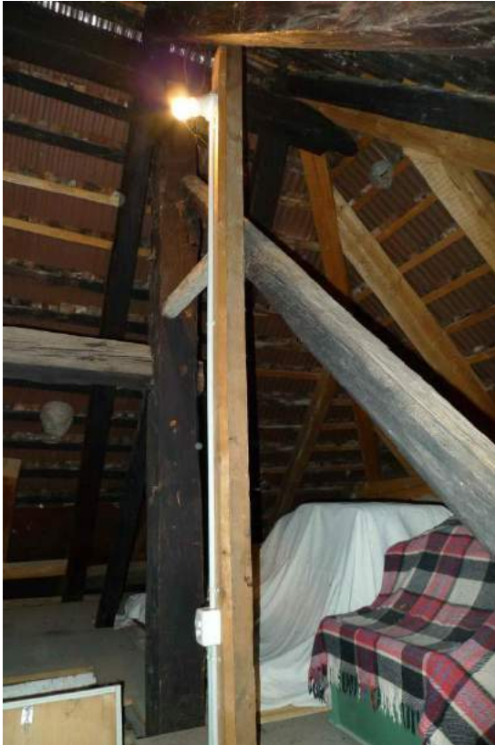
Hochstudkonstruktion westlicher Hausteil Litzihof 10 (2016)
