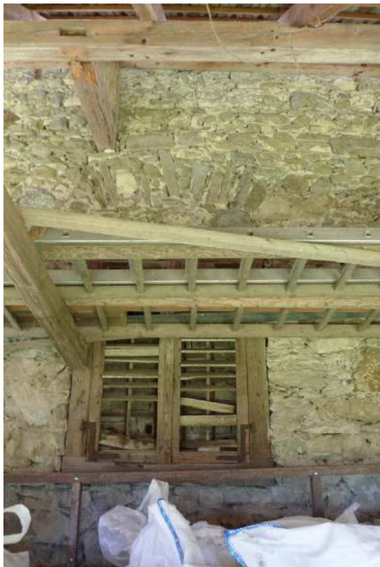
Zugemauertes Fenster am EG, Südfassade (2016)
