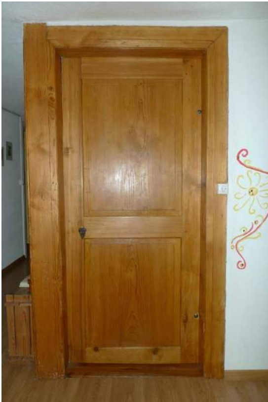
Tür zum Südwestzimmer im nördlichen Hausteil (2016)
