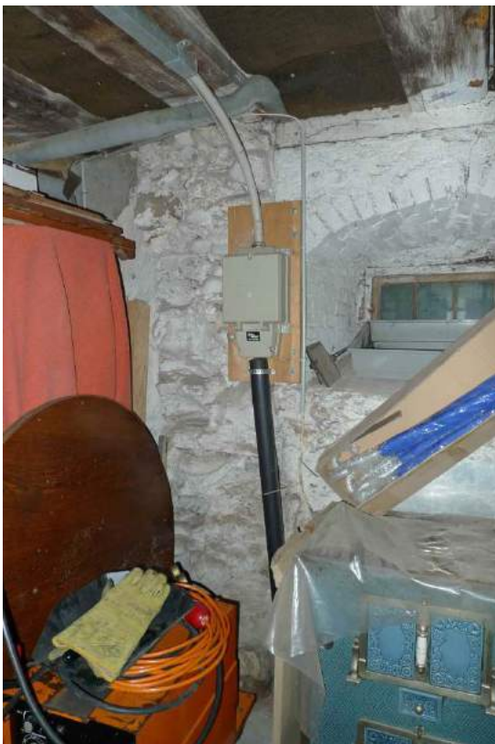
Reste der abgebrochenen Nordmauer im Keller (2016)
