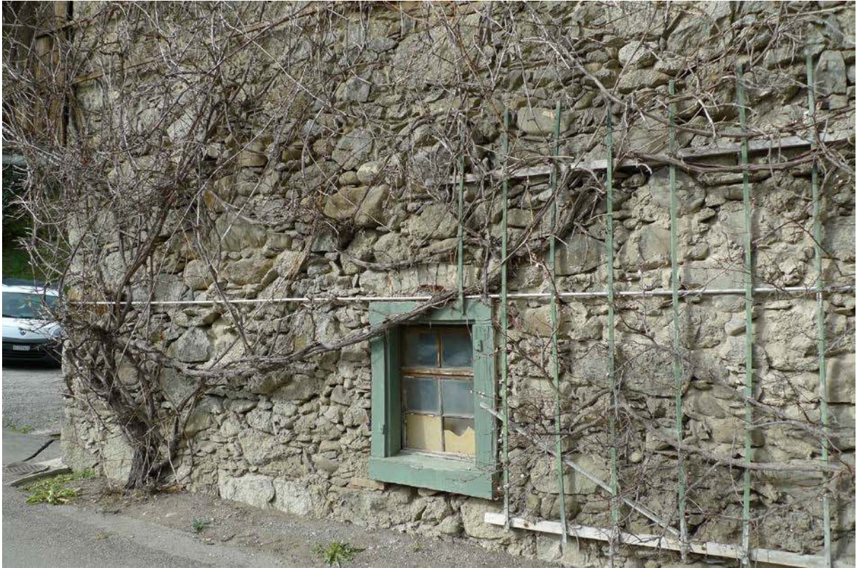
Stallmauer aus Bruch- und Bollensteinen (2016)
