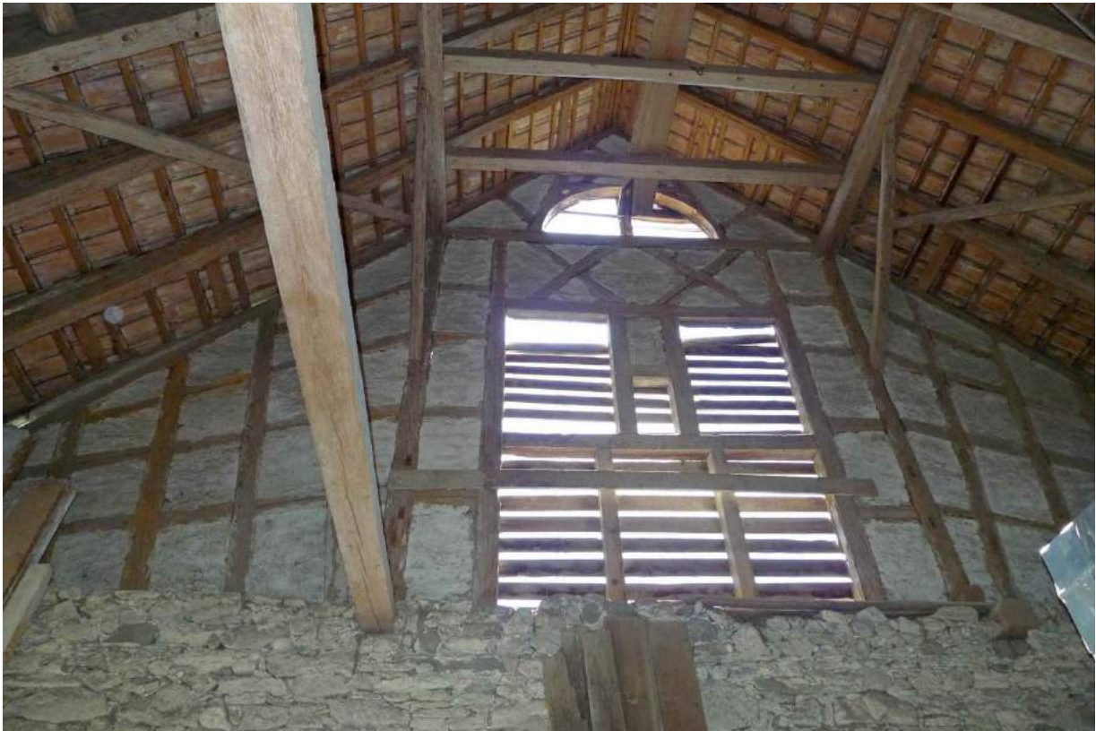
Südlicher Fachwerkgiebel von innen (2016)
