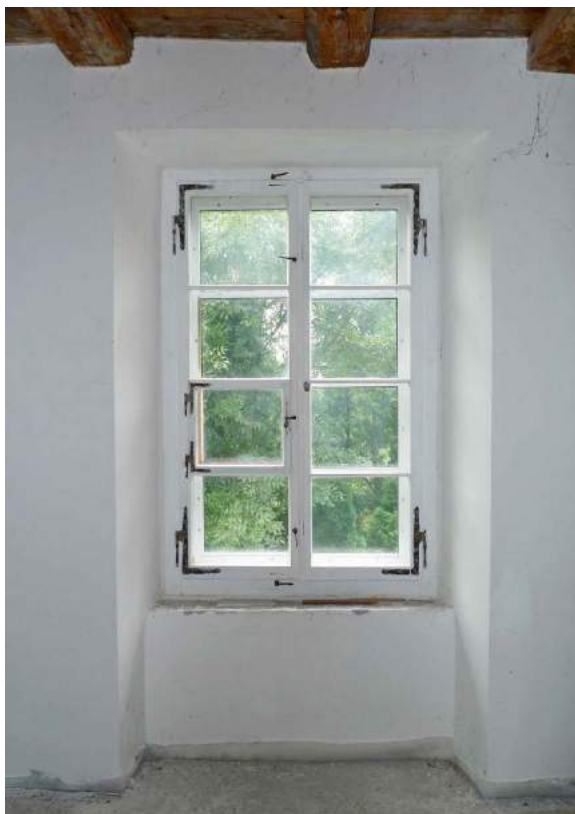
Südseitiges Fenster im 3. OG (2016)
