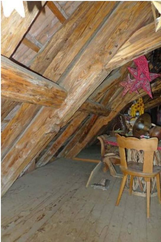
Dachstuhländer mit Wulst, um 1750 (2016)
