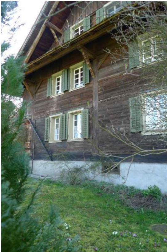
Südliche Stubenfassade mit Fleckling- und Bohlenfüllungen (2016)
