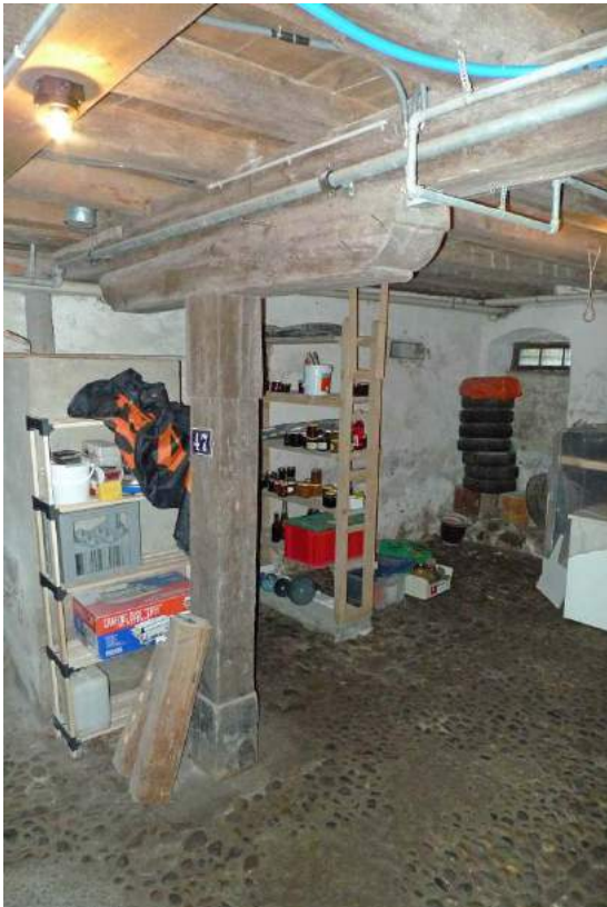
Keller westl. Hausteil, Unterzug mit Stütze (2016)
