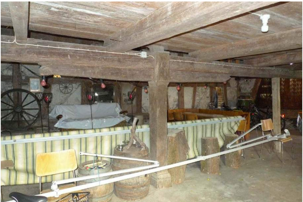
Unterzug und Stütze mit Sattelholz (2016)
