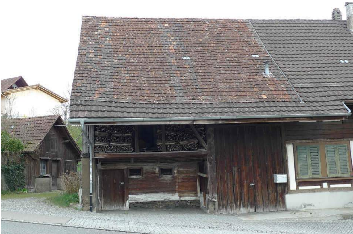
Strassenseitige Fassade Scheunenteil (2016)
