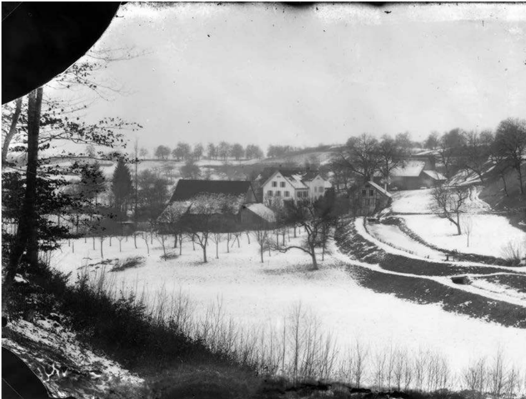
Blick von Osten auf die Baugruppe, um 1900/20 (Fotosammlung Denkmalpflege)
