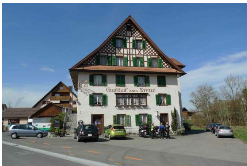
Giebelansicht von Osten (2016)
