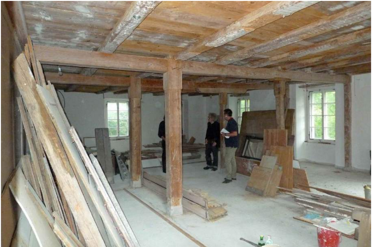
Ehem. Mühlenraum im 3. OG der südöstlichen Gebäudehälfte (2016)
