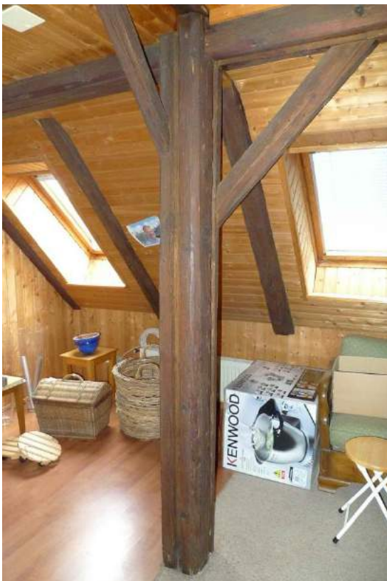
Östlicher Hausteil, ehem. Wandständer im DG (2016)
