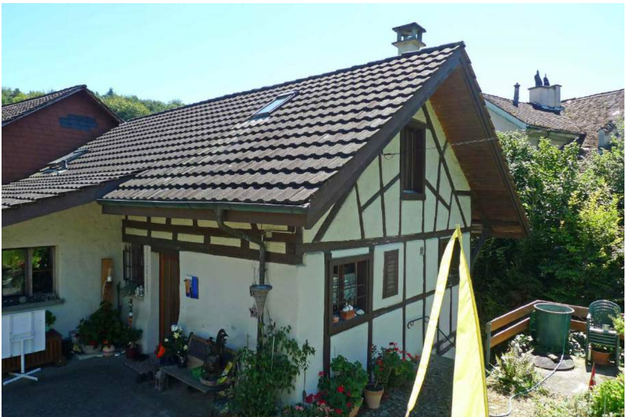
Westl. Hausteil und ehem. Speichergebäude (2016)
