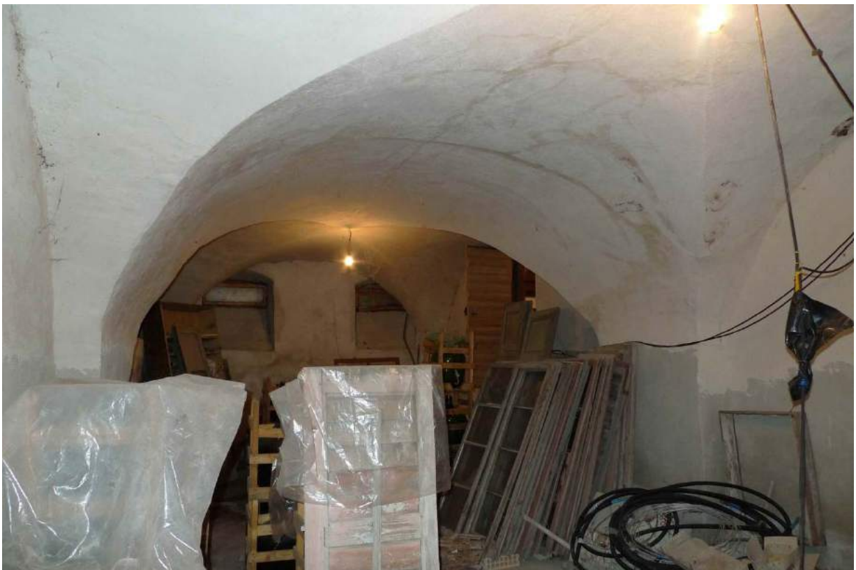
Kellerraum mit doppeltem Kreuzgewölbe (2016)
