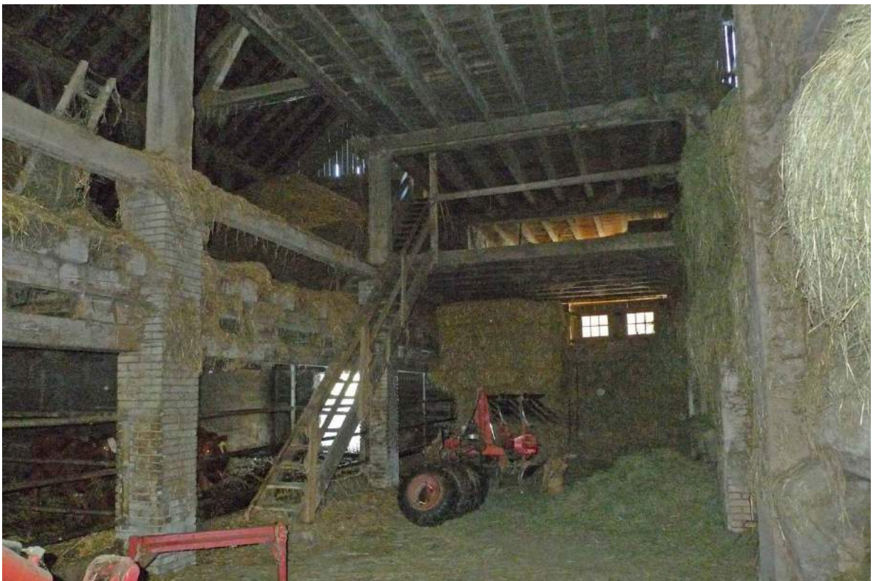
Ständergerüst mit gemauerten Pfeilern, Blick nach Osten (2016)
