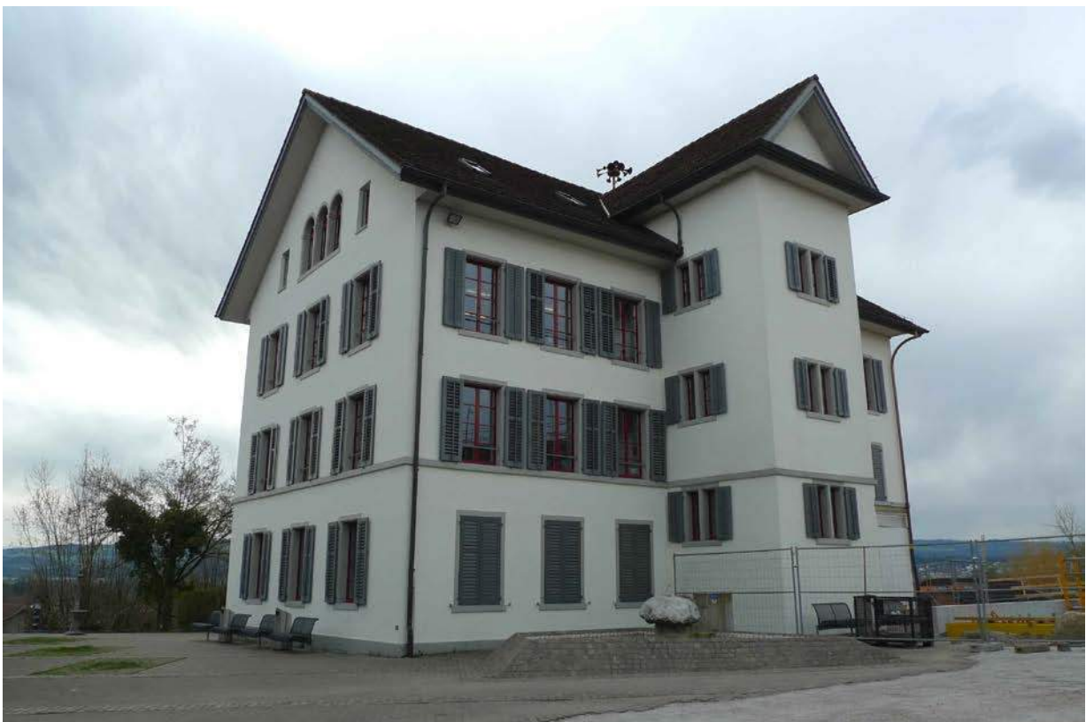
Nördliche Rückseite mit Treppenhausrisalit (2016)
