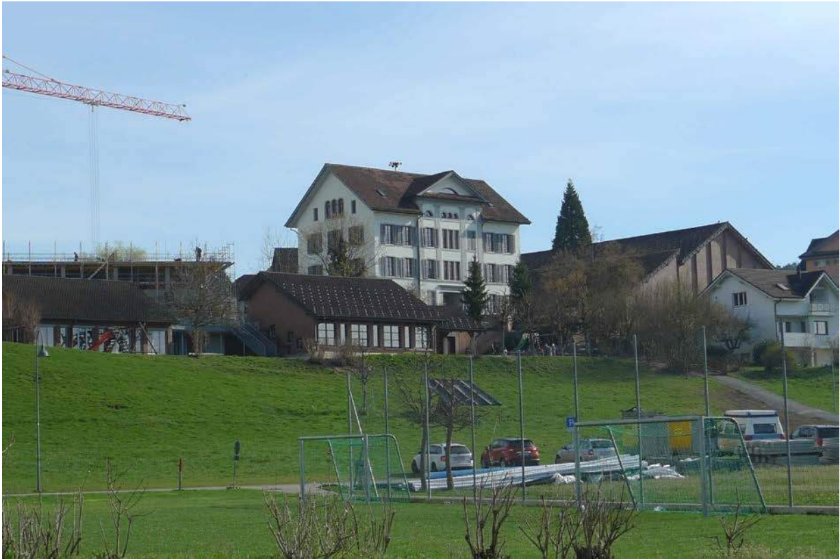
Situationsansicht von Südwesten, mit im Bau befindlicher Schulhauserweiterung (2016)
