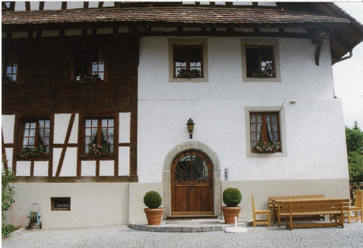
Südöstlicher gemauerter Mühlenteil von 1665 (Kurzinventar 1998)
