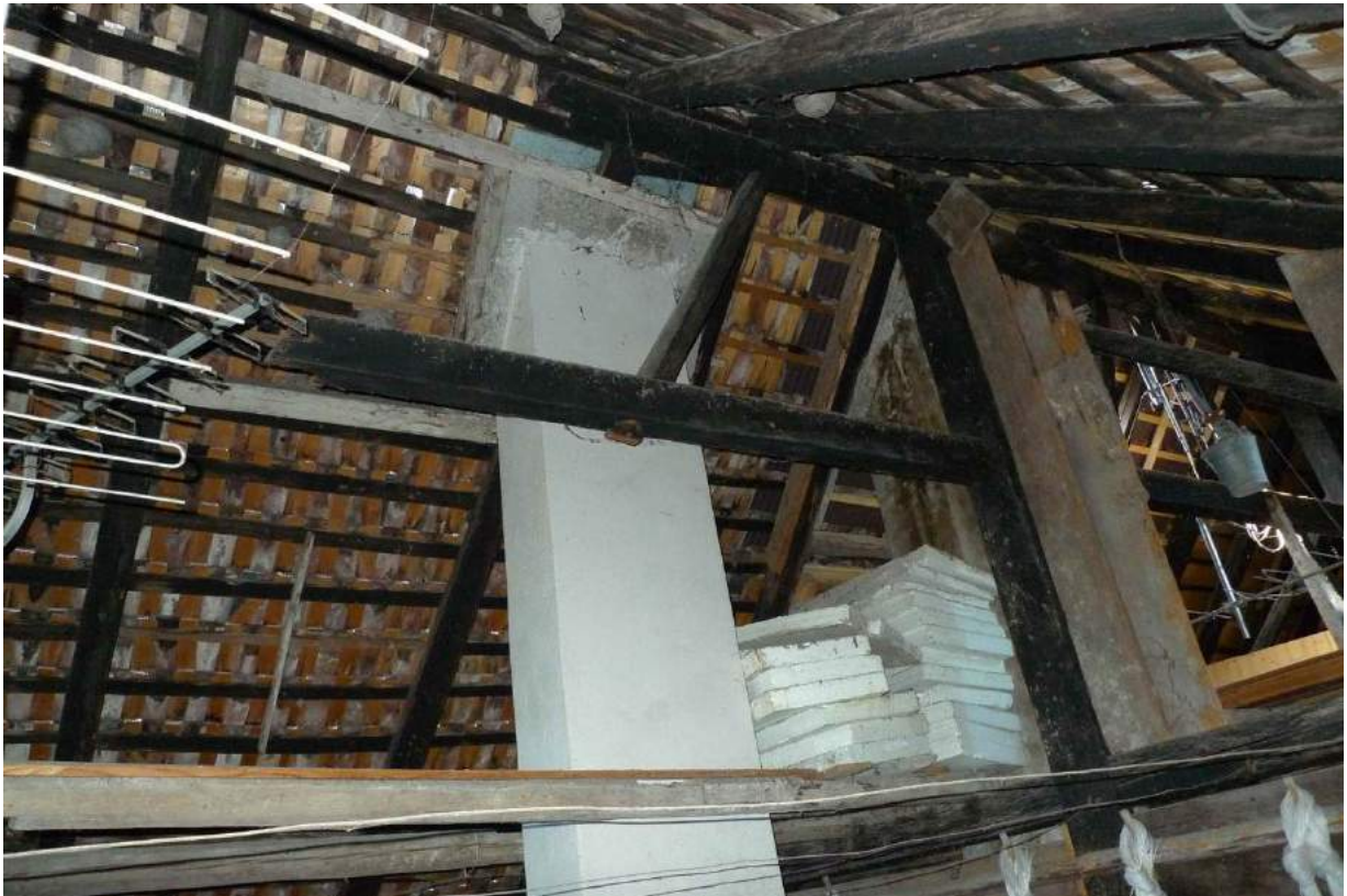
Alte Abwalmung der Hochstudkonstruktion Litzi 16 (2016)
