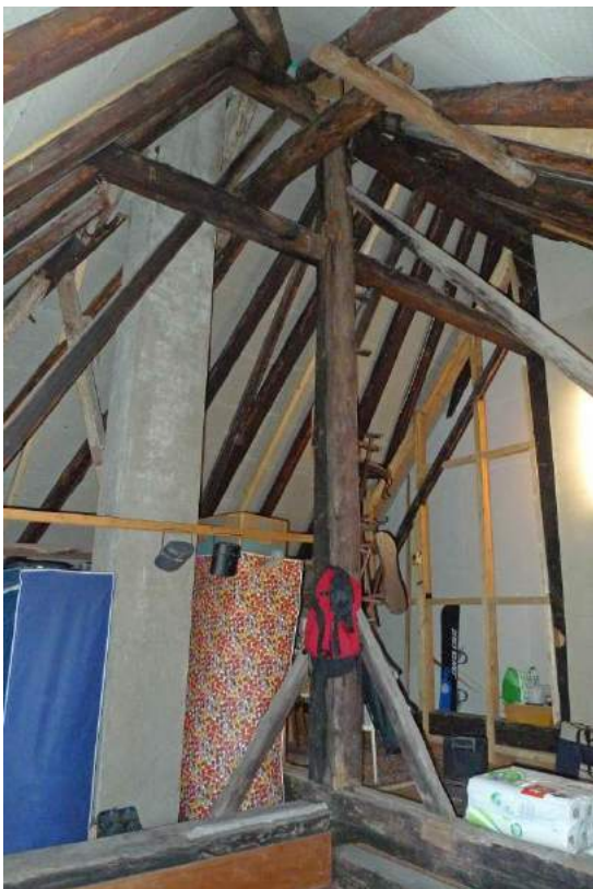
Nordöstlicher Hausteil, Hochstudkonstruktion (2016)
