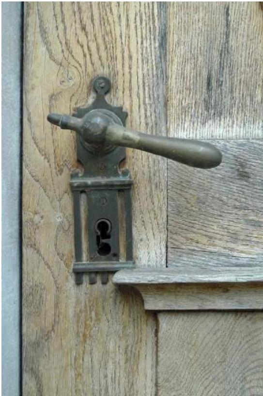
Messingbeschlag Biedermeiertür, westl. Haushälfte (2016)
