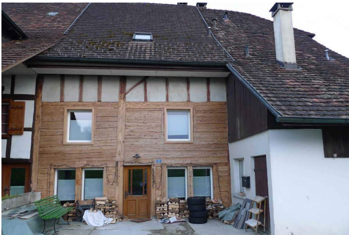
Restaurierte strassenseitige Nordfassade, mit Fleckling-Füllungen, Litzi 12 (2016)
