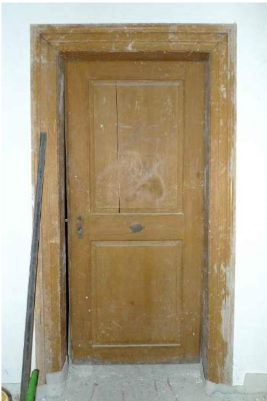
Zweifüllungstür, Farbfassung mit Holzmaserung, 3. OG (2016)
