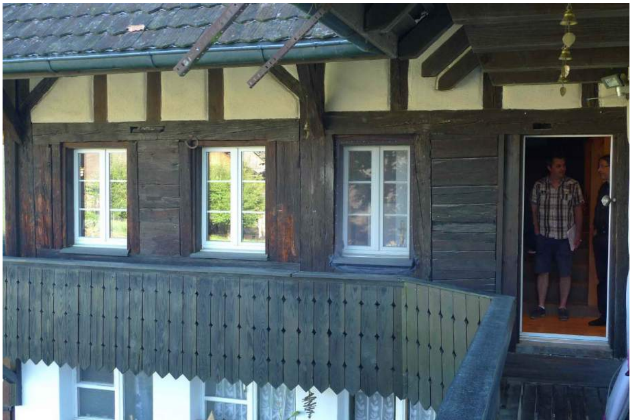
Hölzerne Fassadenteile westlicher Hausabschluss (2016)
