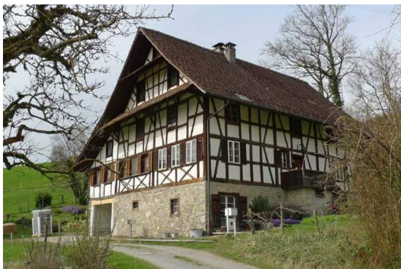
Ansicht von Südosten (2016)
