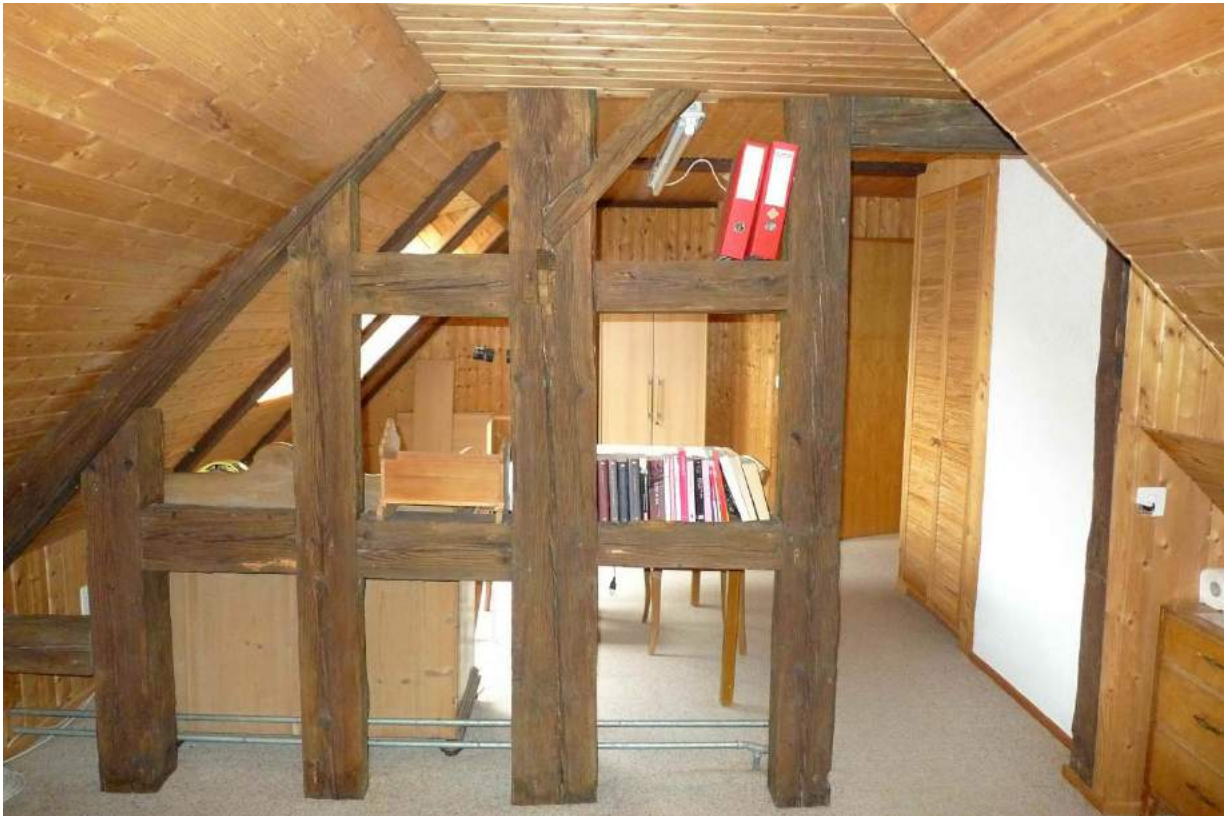
Östl. Hausteil, Fachwerkgiebel der ehem. Aussenwand (2016)
