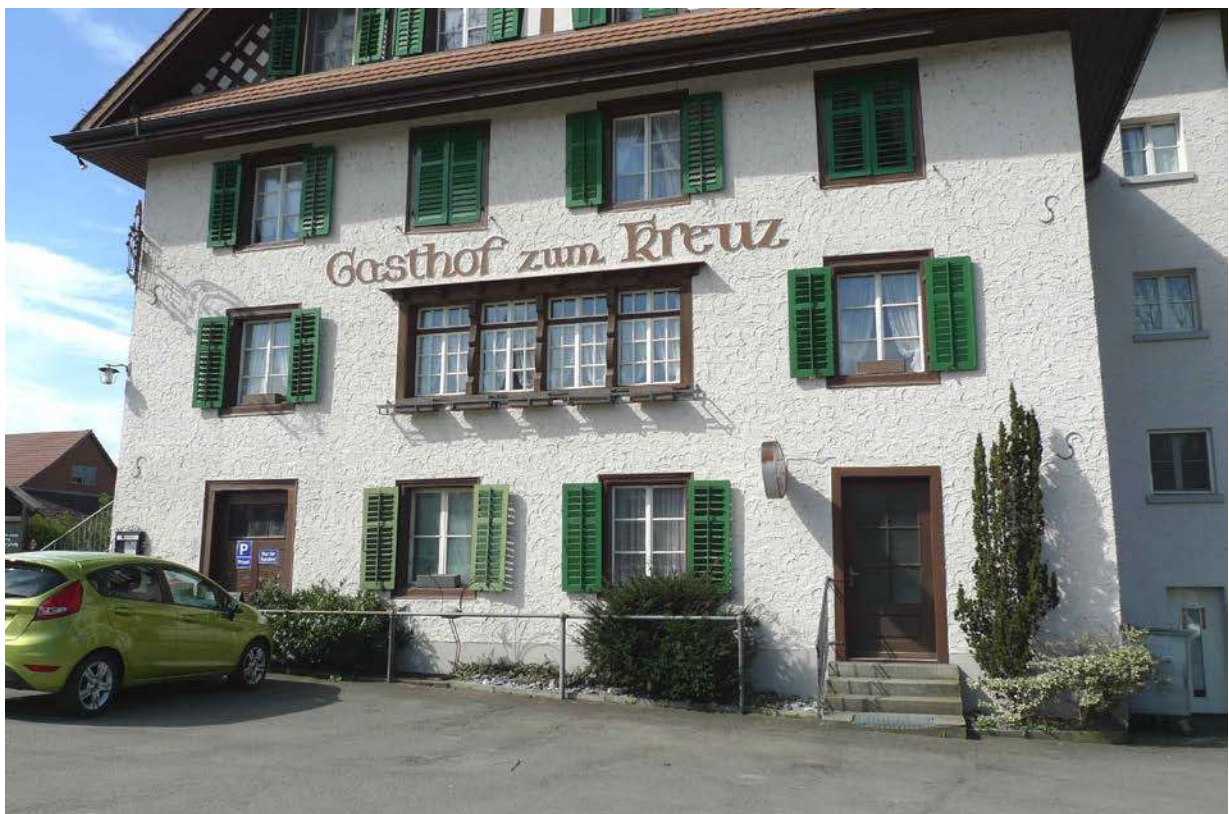
Ostfassade mit Reihenfenster in Heimatstilformen vor der alten Gaststube (2016)
