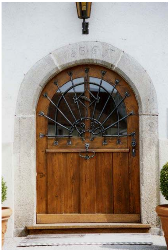
Rundbogiger Mühleneingang (Kurzinventar 1998)
