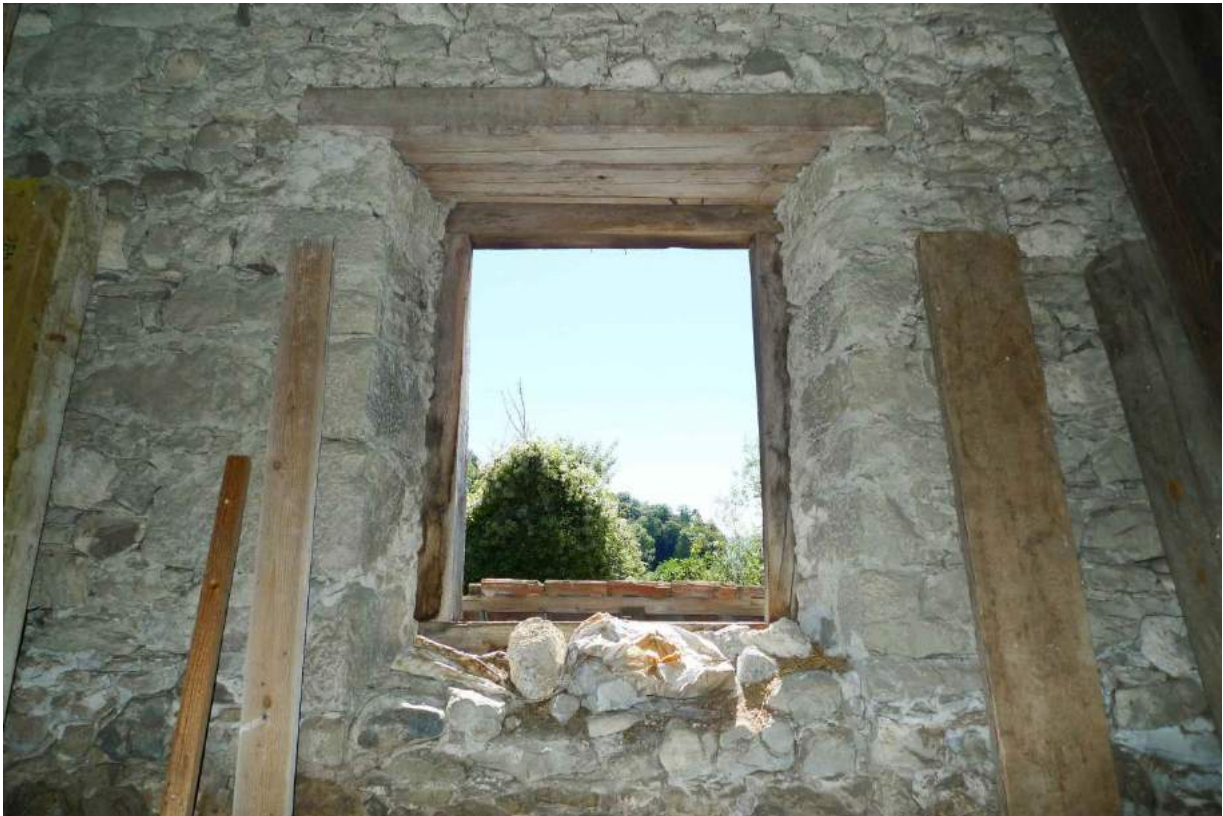
Fenster in der südlichen Giebelmauer (2016)
