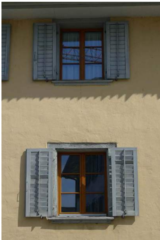
Kleinformatige Einzelfenster mit hölzernen Gewänden (2016)
