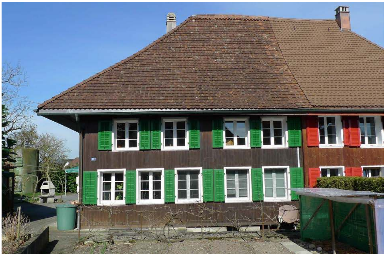
Vorderseite südwestlicher Hausteil (2016)
