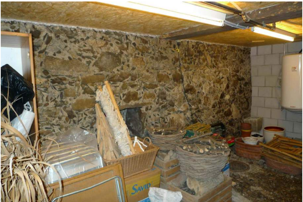
Massive Kellermauer aus Bruch- und Bollensteinen, Litzi 10 (2016)
