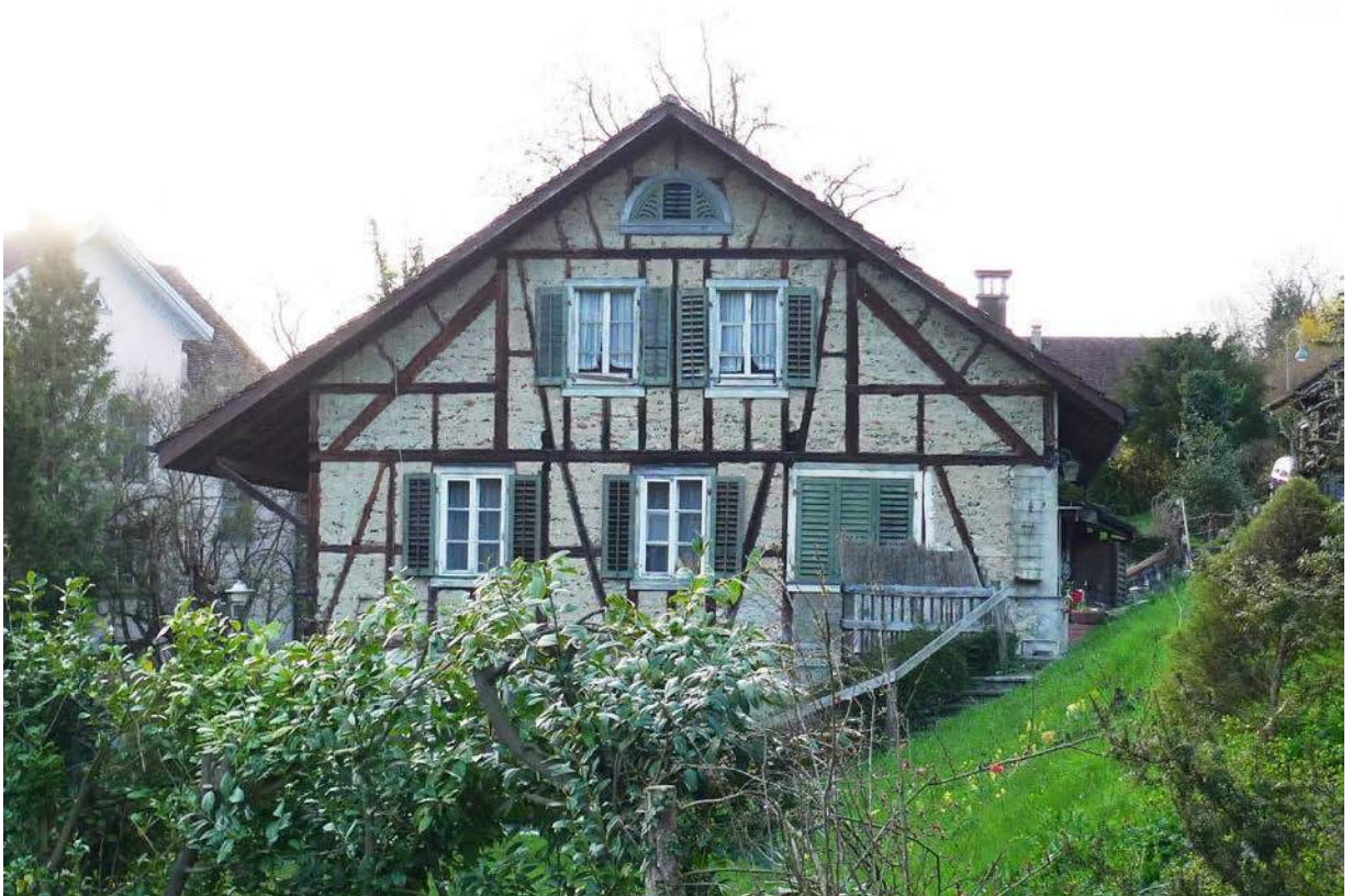
Ostfassade des Hausteils von 1887 (2016)
