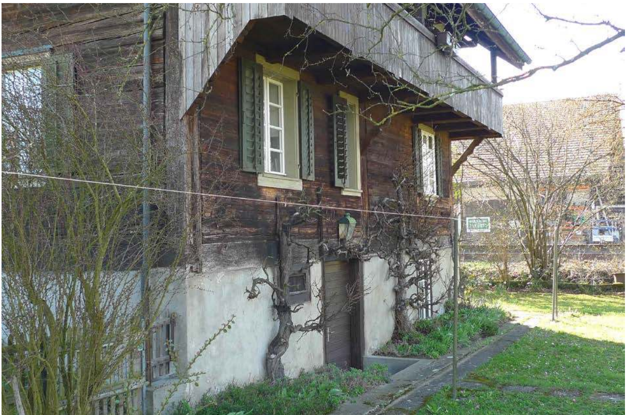
Westfassade mit Kellereingang (2016)
