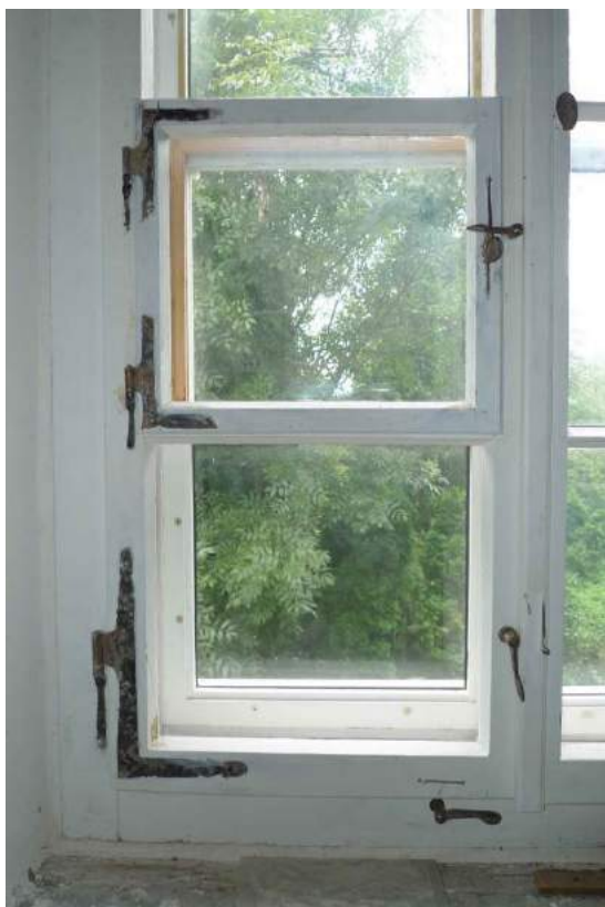
Lüftungsfenster und originale Beschläge, Fenster im 3. OG (2016)
